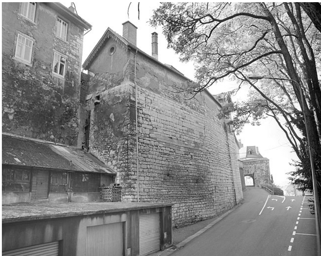
Enceinte. Partie sous la basse-cour (o). 25, Montbéliard rue du Château
