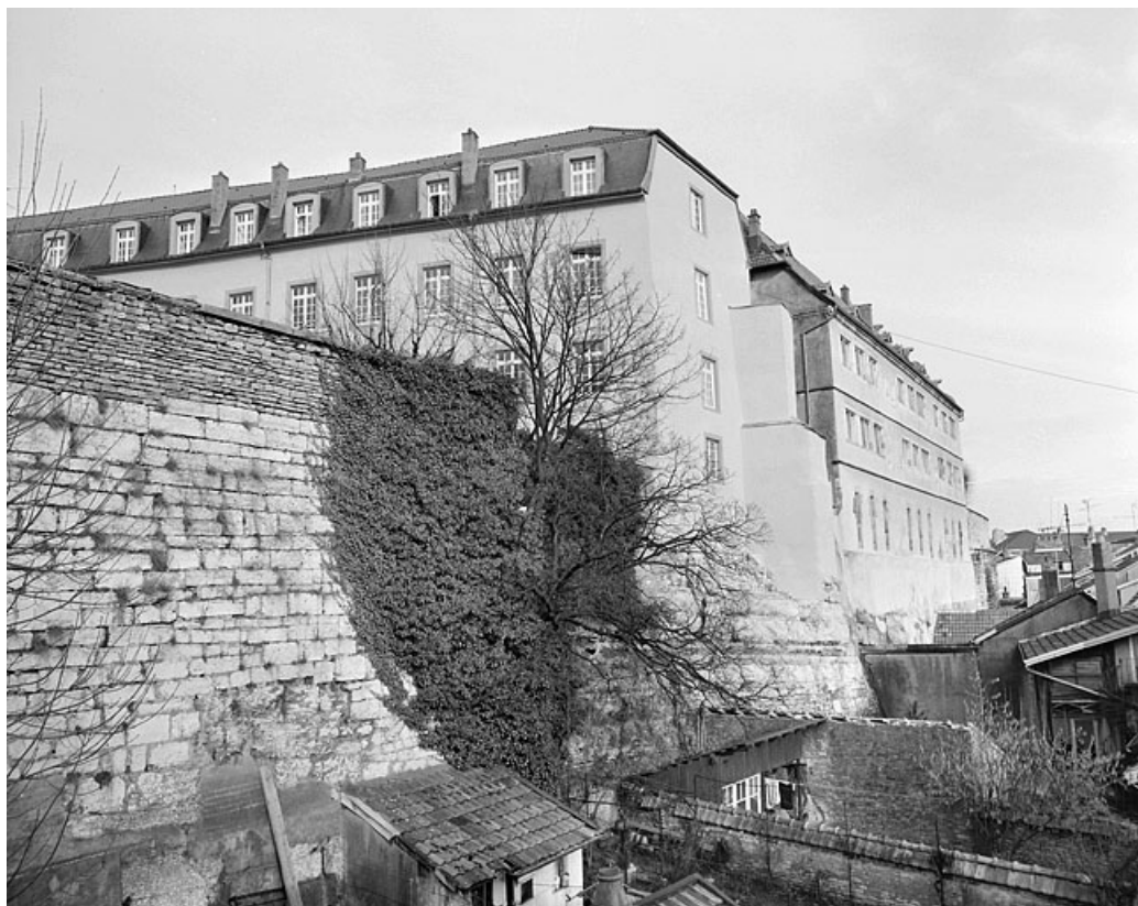
Enceinte. Partie sous le Vieux Château (k). 25, Montbéliard rue du Château
