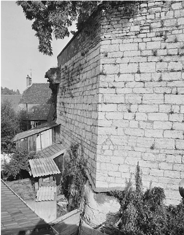
Enceinte. Partie sous le Vieux Château (h). 25, Montbéliard rue du Château
