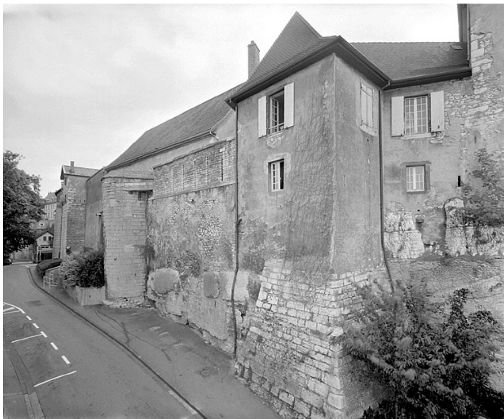
Enceinte. Partie près de la porte (d). 25, Montbéliard rue du Château
