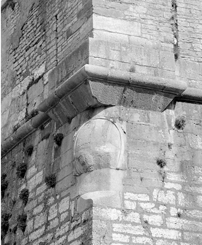
Enceinte. Blason bûché sous le Neuf Château (1).
