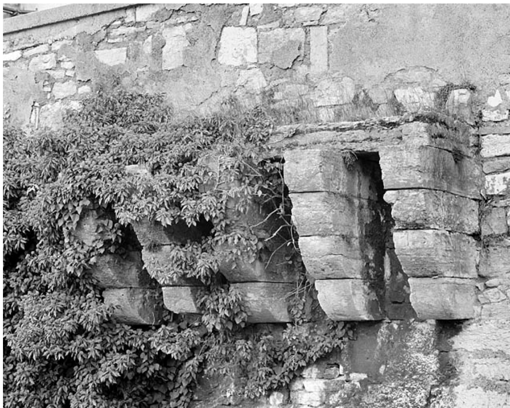
Enceinte. Partie sous le Vieux Château (g). 25, Montbéliard rue du Château
