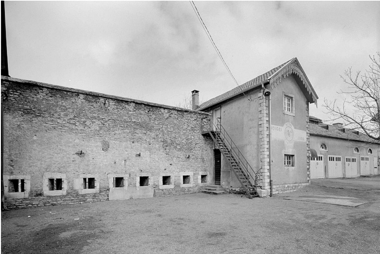
Enceinte. Partie vue de la basse-cour (p). 25, Montbéliard rue du Château
