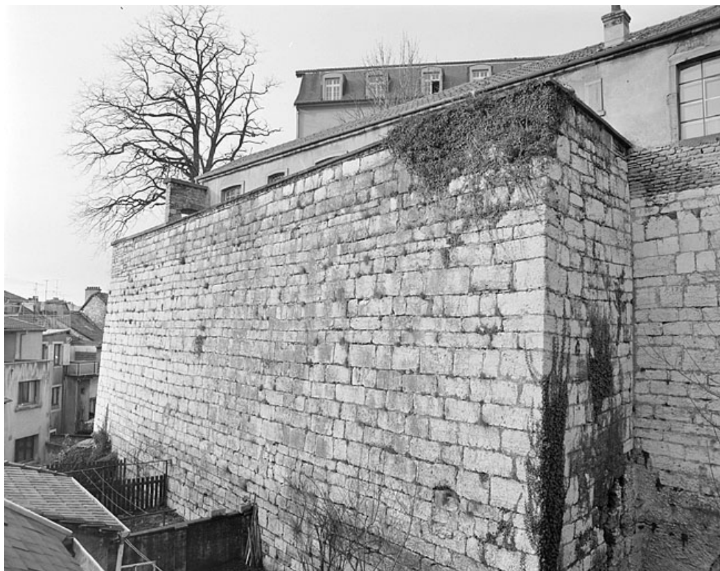
Enceinte. Partie sous le Vieux Château (j). 25, Montbéliard rue du Château
