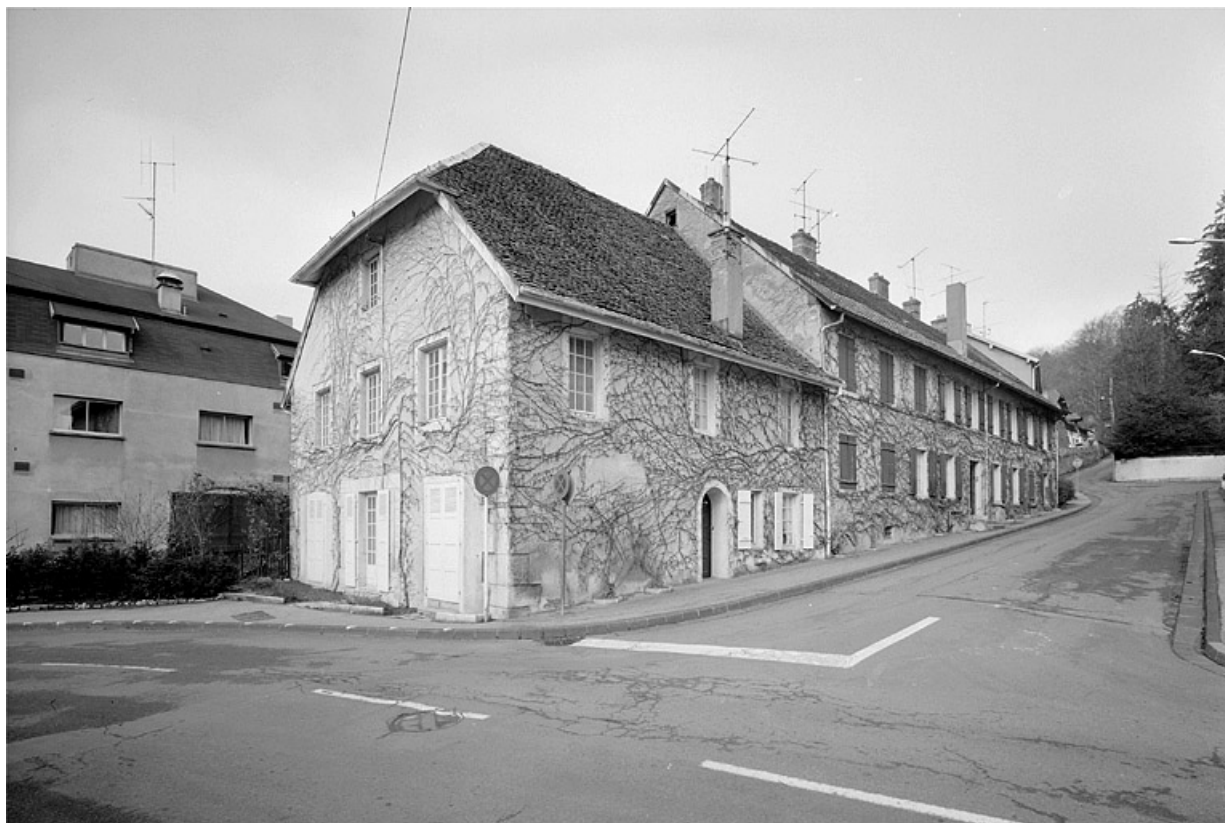
Vue d'ensemble des façades sud et est.
