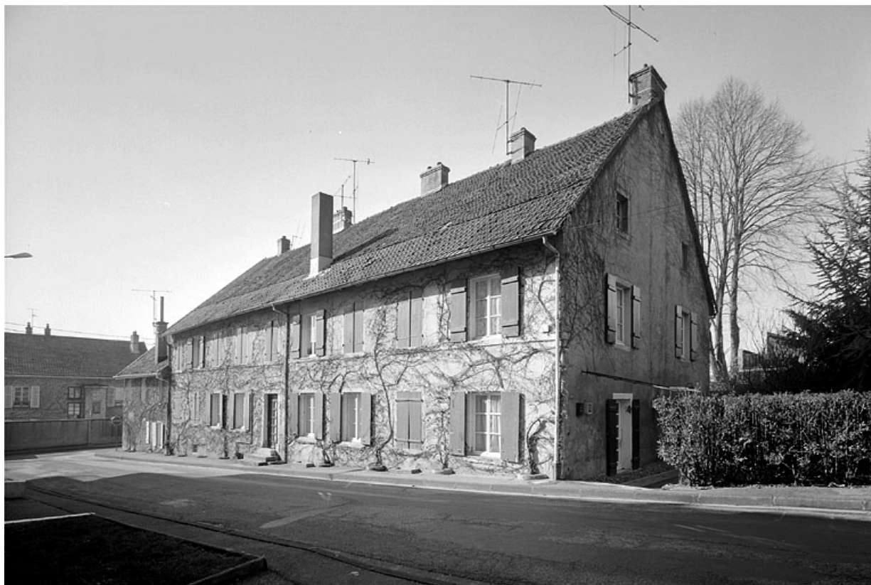
Vue d'ensemble de la façade est. 25, Montbéliard, 9 rue de la Tuilerie
