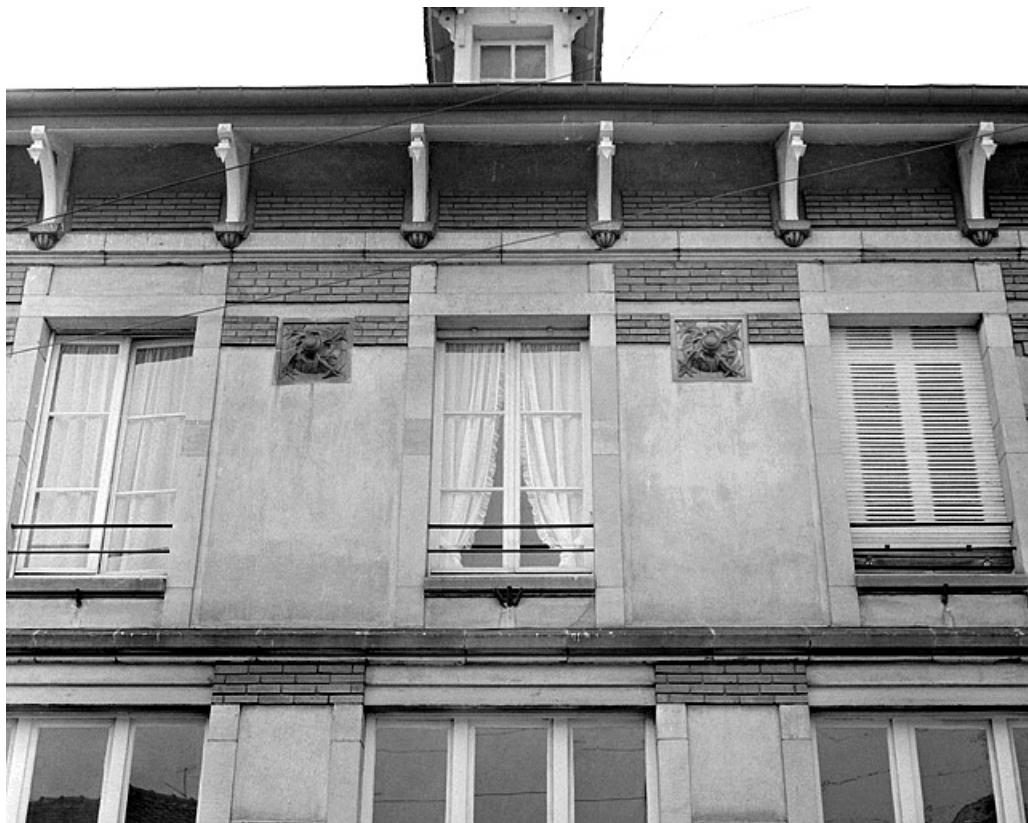
Détail de la façade sur la rue du Puits.
