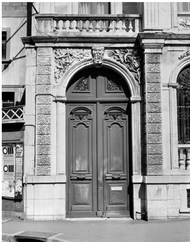
Banque. Façade principale, porte cochère. 25, Montbéliard, 13 place Saint-Martin
