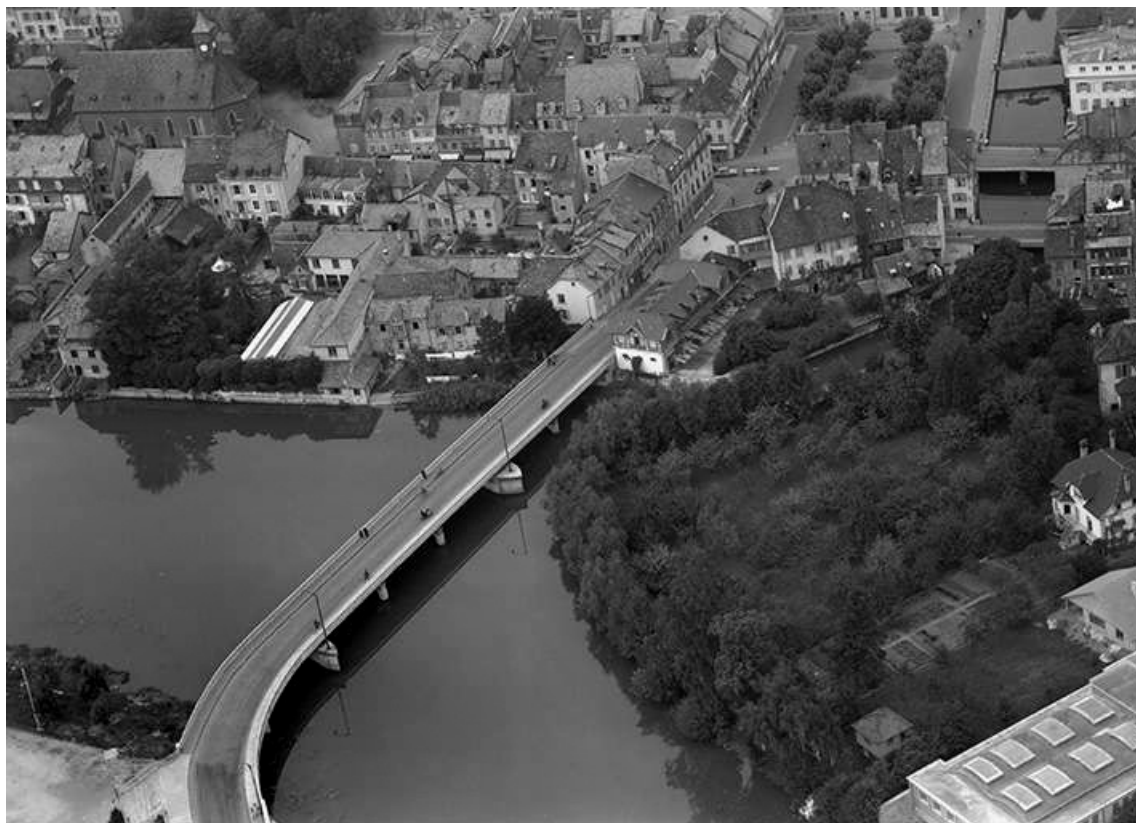
Vue aérienne du pont en 1956.
