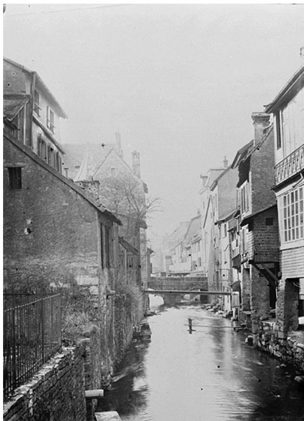
Le canal de la Schliffe et le pont des Eaux, côté amont, fin 19e ou début 20e siècle. 25, Montbéliard rue des Eaux
