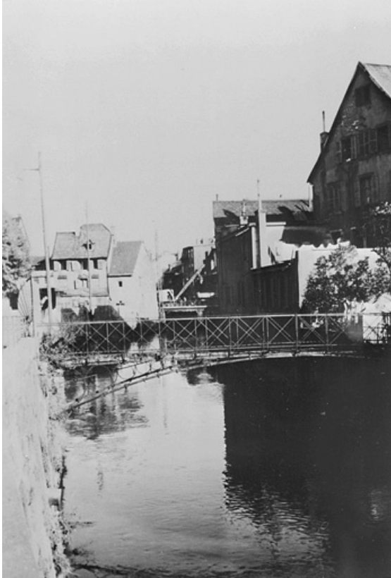
Passerelle de la tannerie Lods-Perdrizet [côté aval], début 20e siècle. 25, Montbéliard rue des Huisselets
