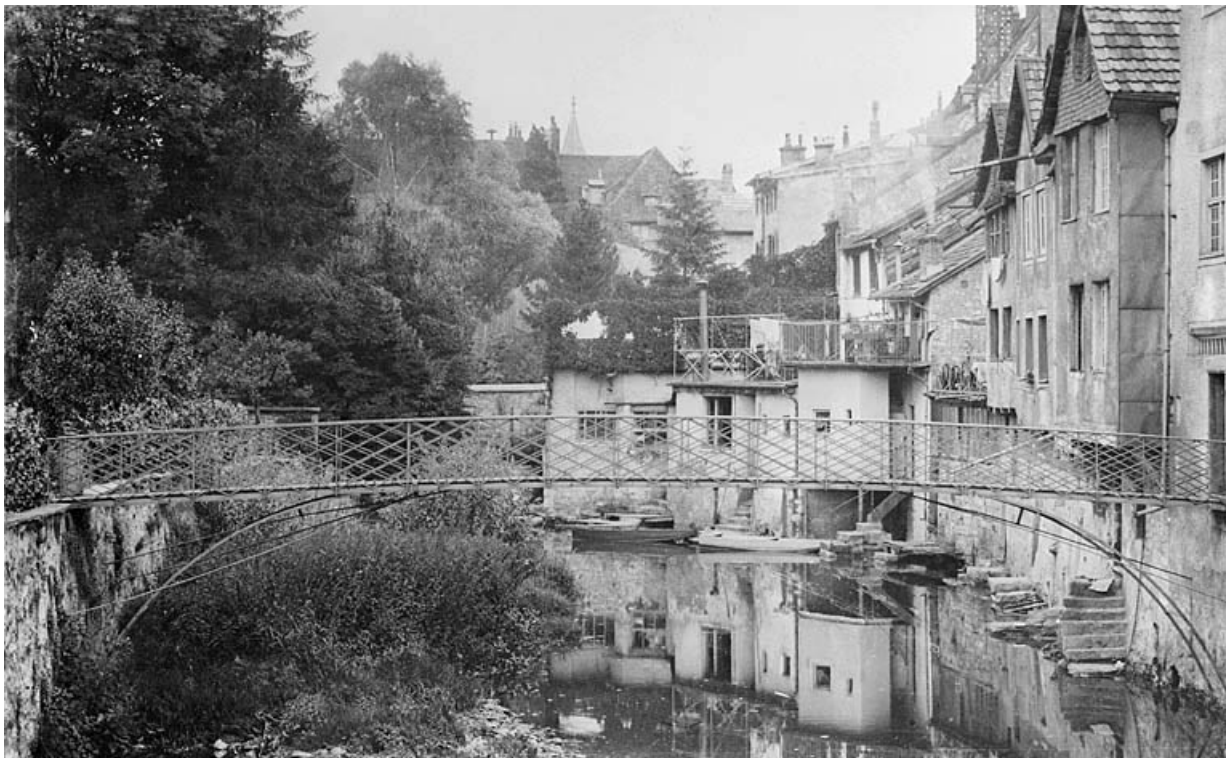
Passerelle de la maison 34, rue des Halles, milieu 20e siècle. 25, Montbéliard
