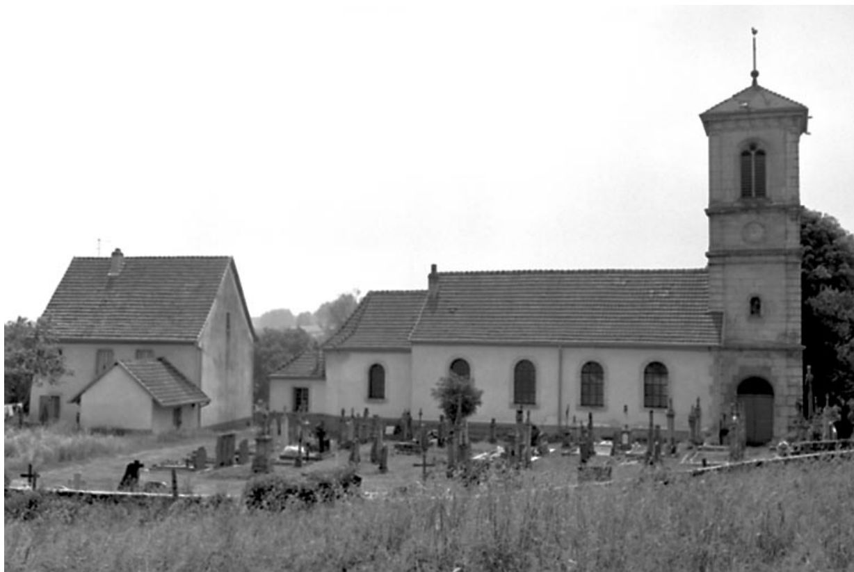
Vue de la façade latérale gauche.
