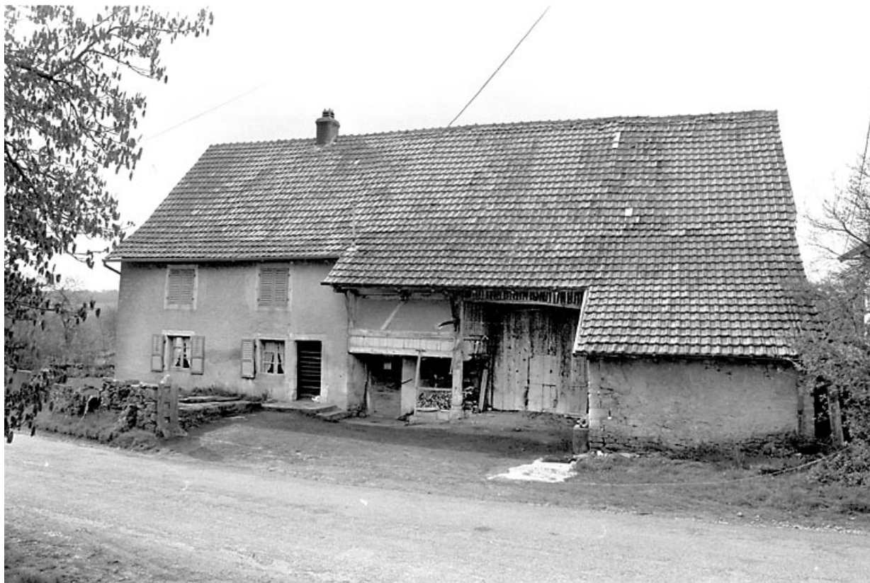
Façade antérieure sur rue. 90, Saint-Dizier-l'Évêque
