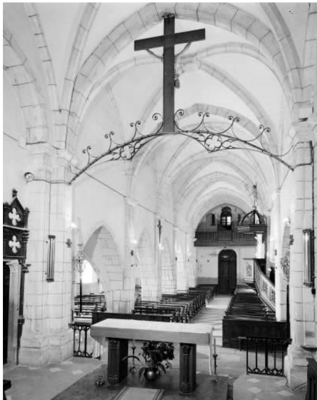
La nef vue du chœur.
