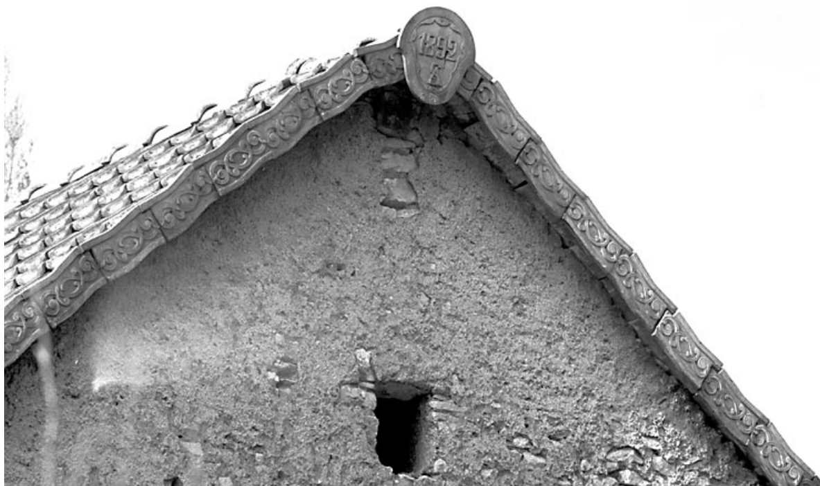
Vue du pignon droit de la remise.
