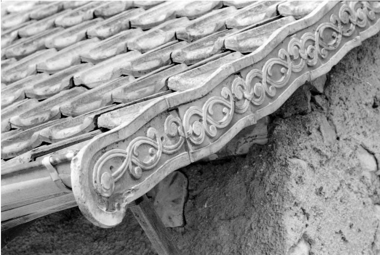
Pignon droit de la remise : détail.
