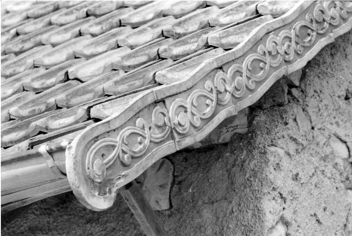
Pignon droit de la remise : détail.
