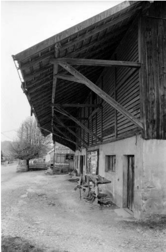
Partie agricole : avant-toit sur façade antérieure.
