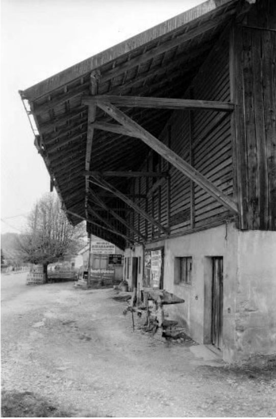
Partie agricole : avant-toit sur façade antérieure.
