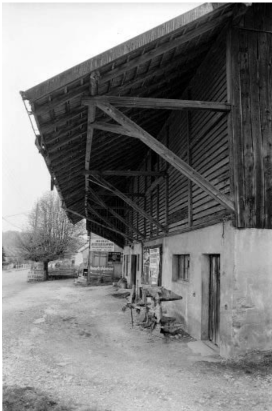
Partie agricole : avant-toit sur façade antérieure.
