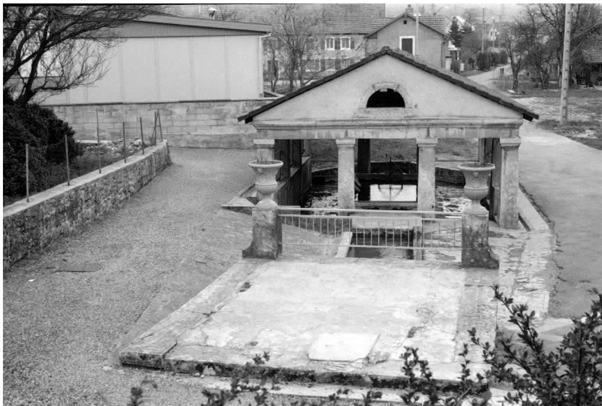
Ensemble du dispositif avec, au 1er plan, la chambre de captage. 90, Fêche-l'Église
