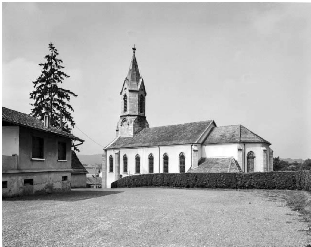
Façade latérale droite et chevet. Au 1er plan, l'emplacement de l'ancien cimetière transformé en aire de stationnement. 90, Fêche-l'Église
