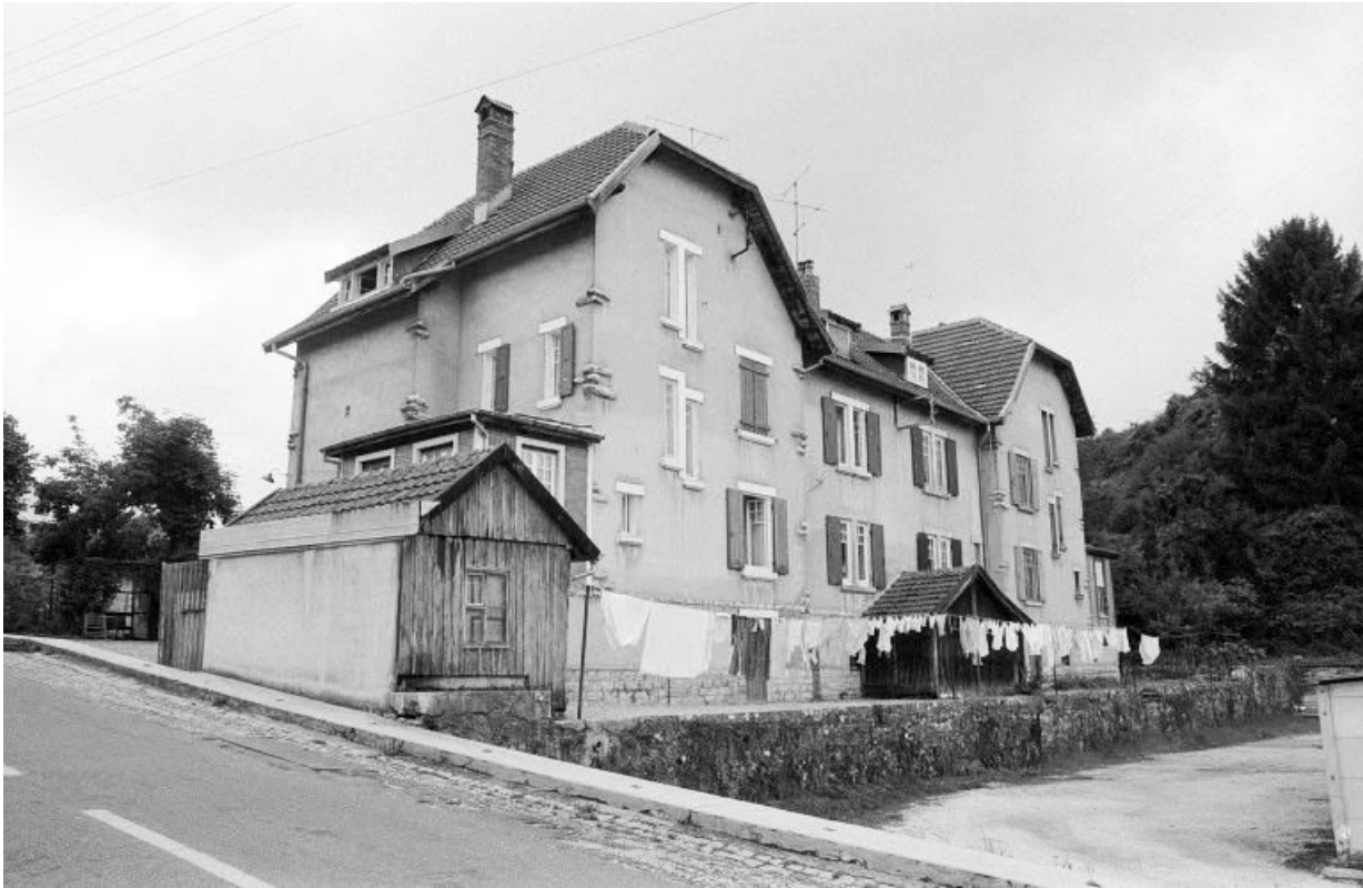
Vue d'ensemble : façade postérieure. 90, Beaucourt Montbouton
