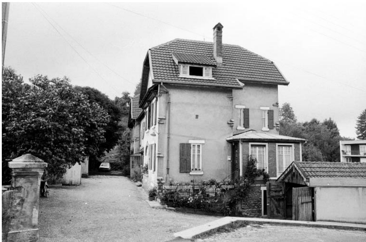
Façade antérieure et latérale droite.
