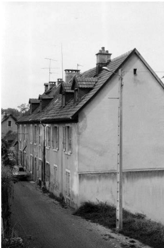
Façades antérieure et latérale droite.
