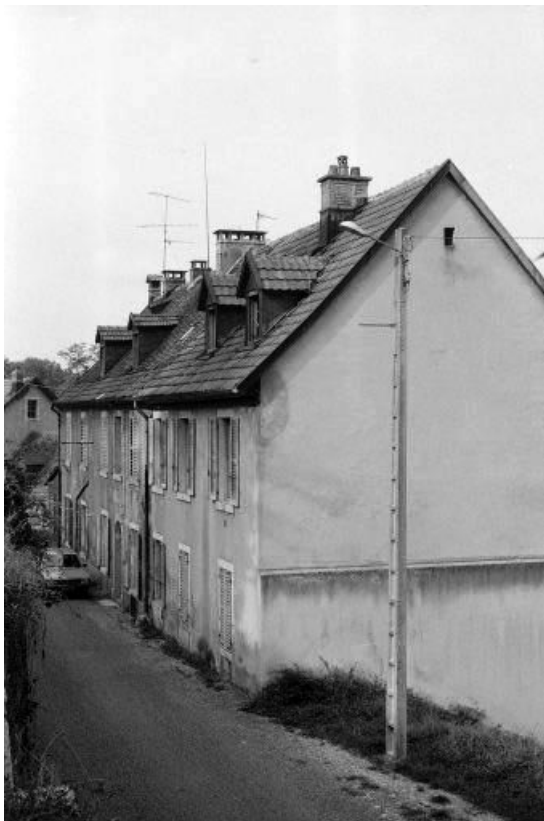
Façades antérieure et latérale droite.
