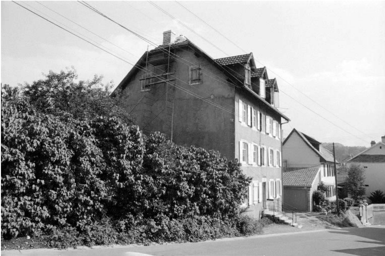
Façades antérieure et latérale gauche. 90, Beaucourt Eglise
