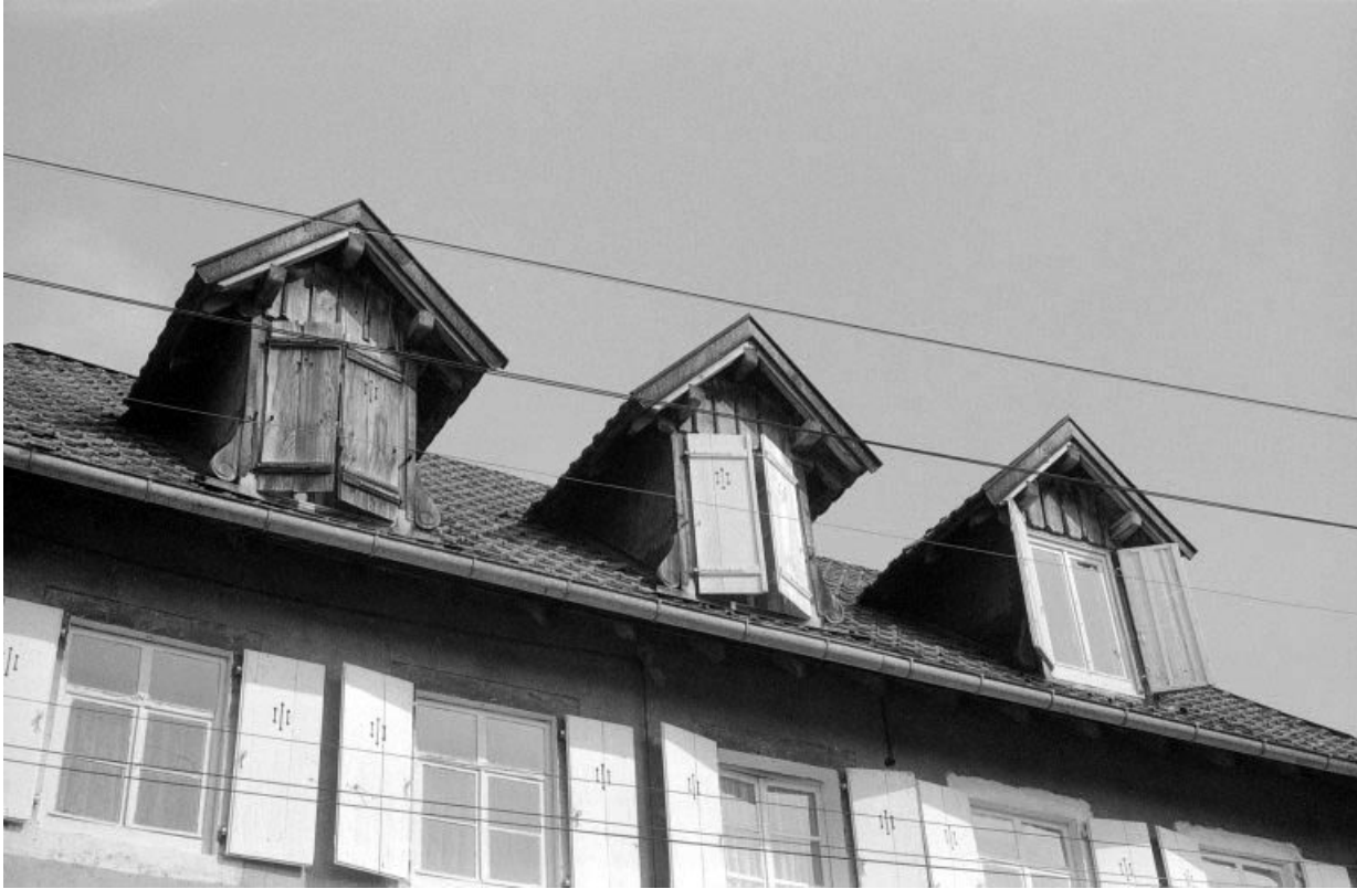
Façades antérieure : détail des lucarnes.
