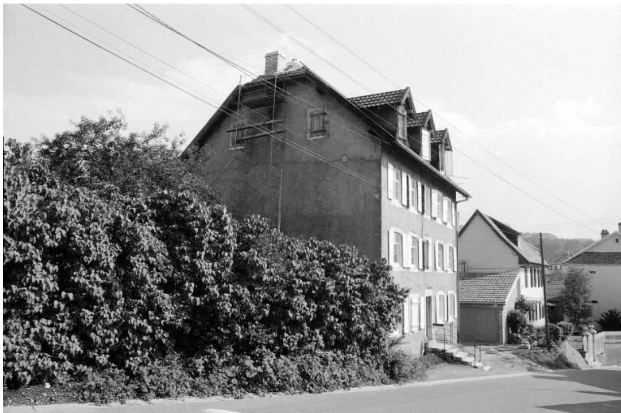
Façades antérieure et latérale gauche.
