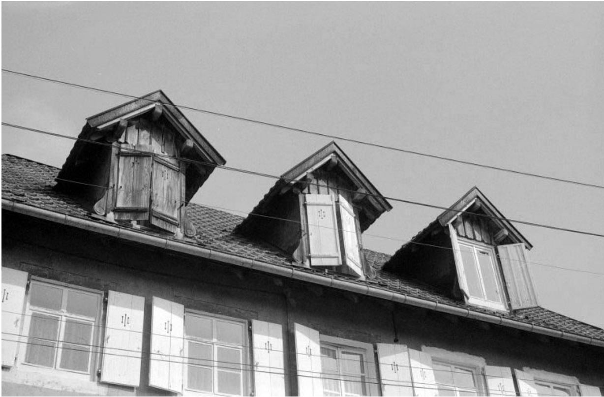
Façades antérieure : détail des lucarnes.
