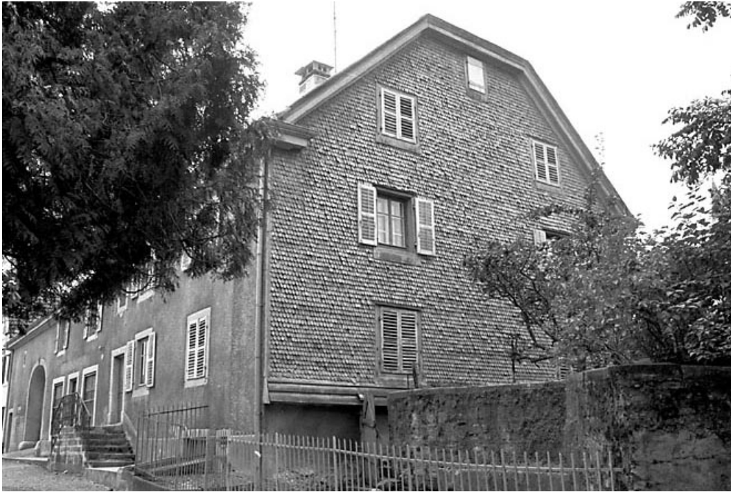
Façades antérieure et latérale droite.
