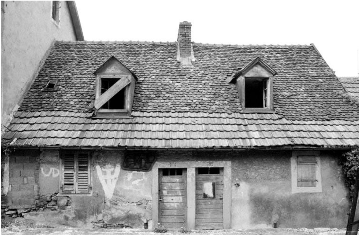
Elevation antérieure, rue de la Poste.
