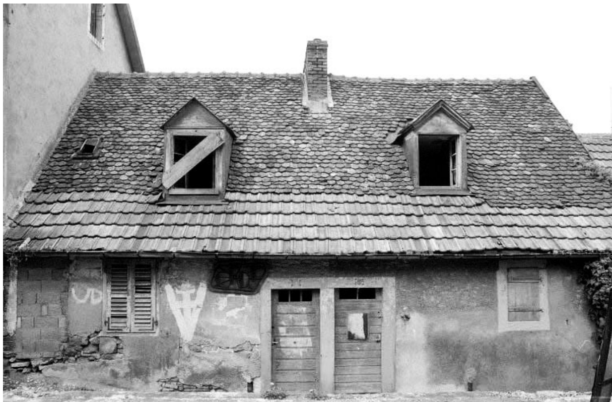
Elevation antérieure, rue de la Poste.
