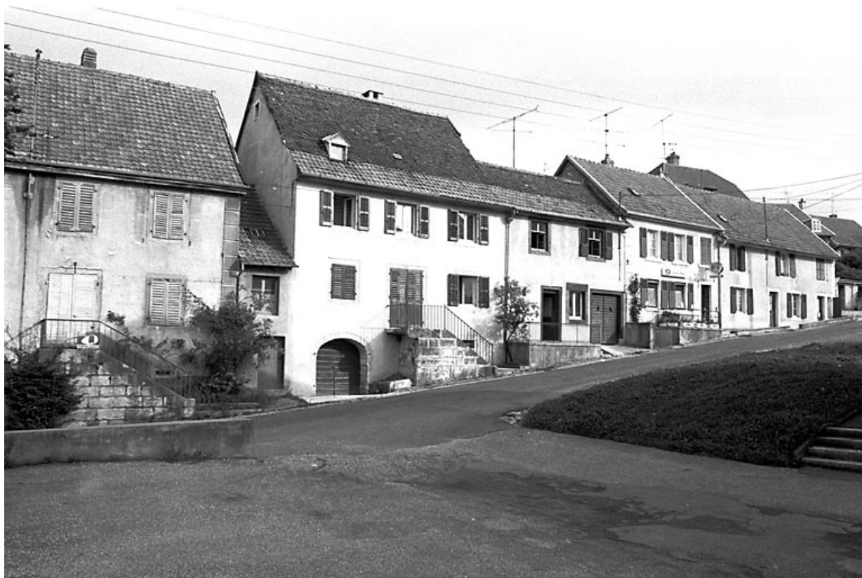
Situation dans l'alignement de maisons, rue de Montbouton.
