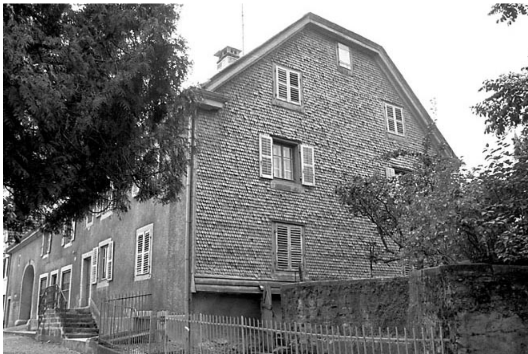
Façades antérieure et latérale droite.
