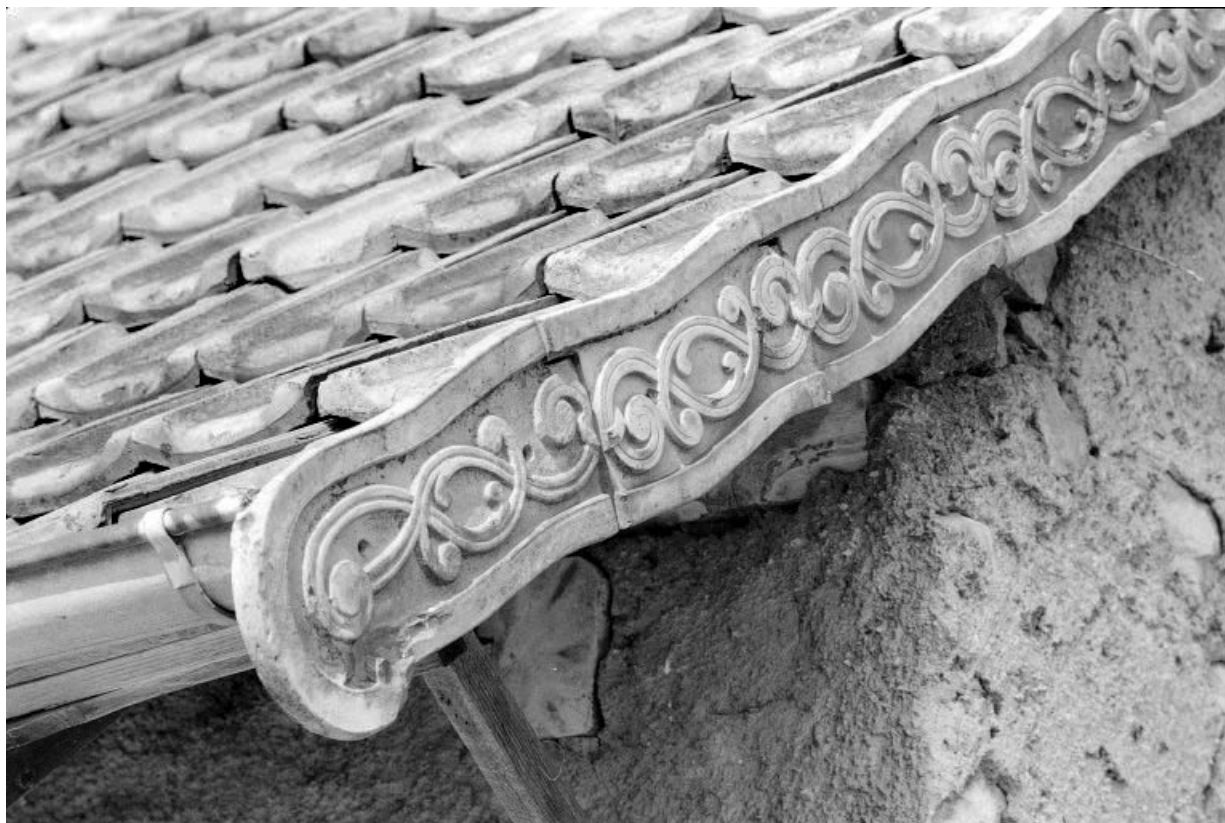
Pignon droit de la remise : détail.
