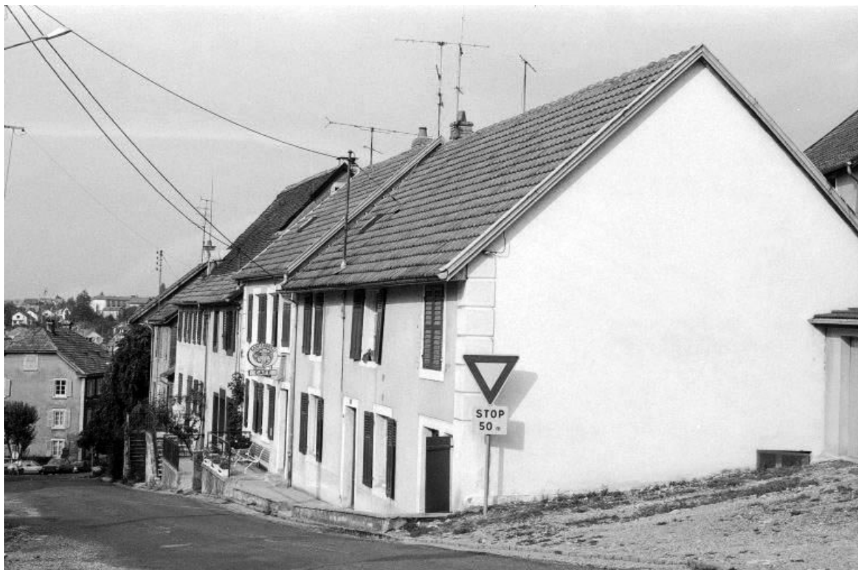
Alignement de maisons, rue de Montbouton.
