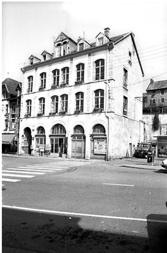
Façades antérieure et latérale droite.
