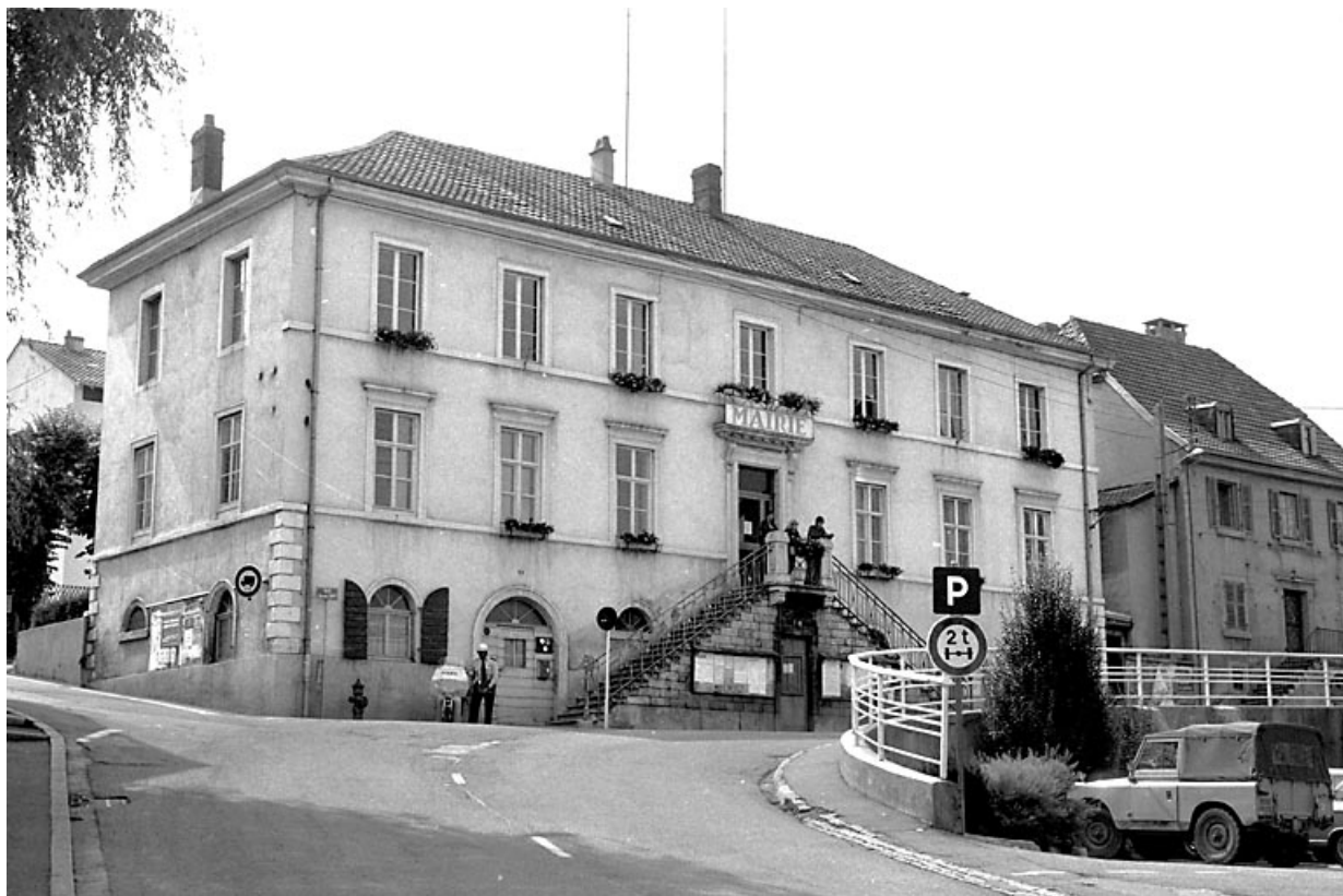
Façades antérieure et latérale gauche.
