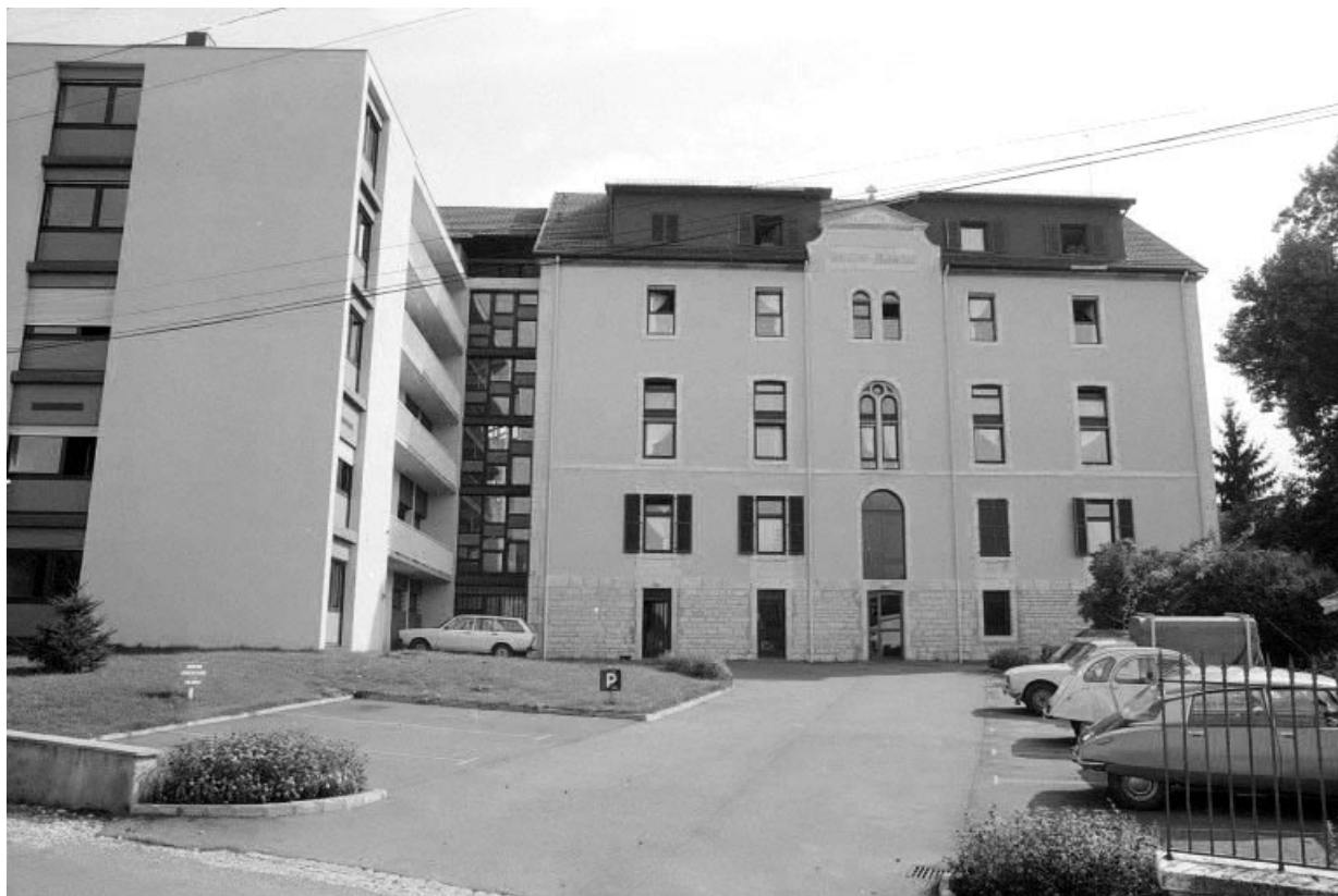
Façade antérieure et annexe. 90, Beaucourt Maison Blanche
