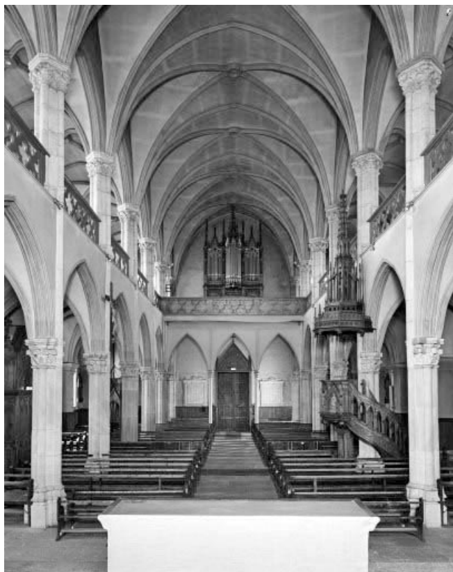
La nef vue du chœur.
