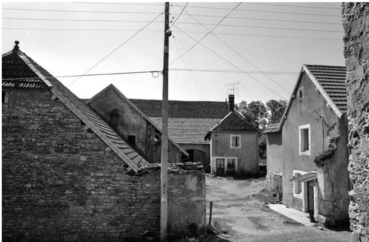
Vue d'ensemble depuis la rue.
