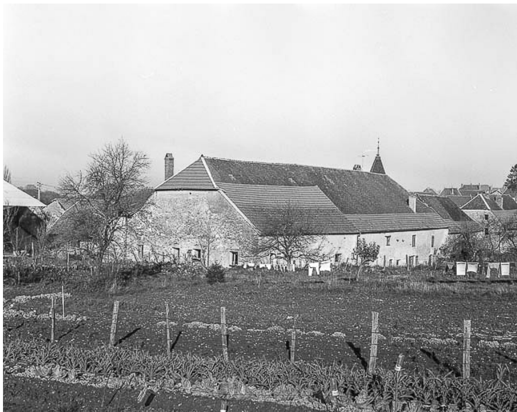
Façade postérieure : vue éloignée
