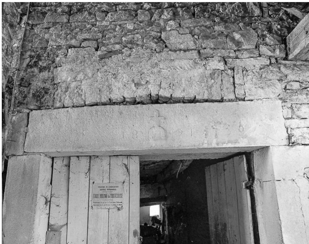
Détail : linteau de la porte d'écurie.
