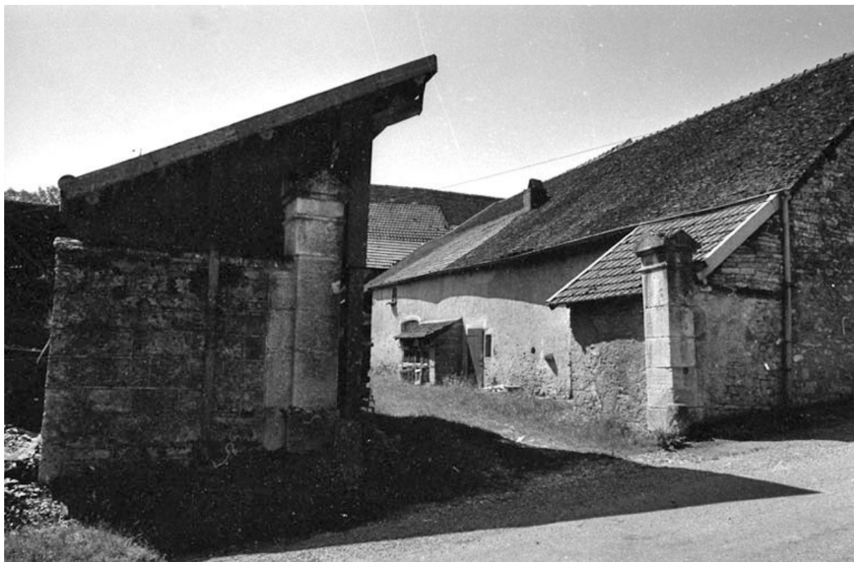
Vue depuis l'entrée de la cour.
