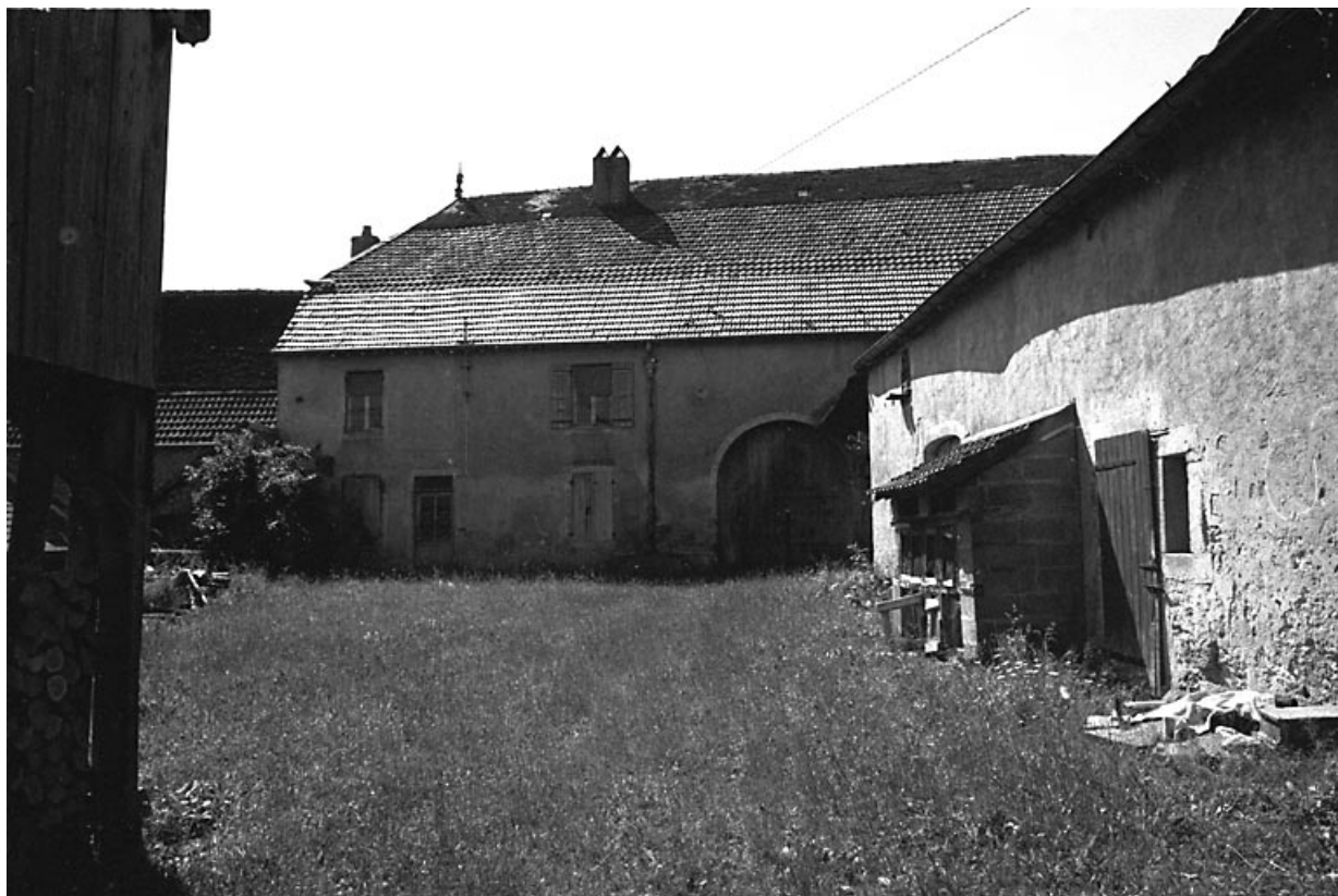
Bâtiment de ferme en fond de cour et dépendances à droite.
