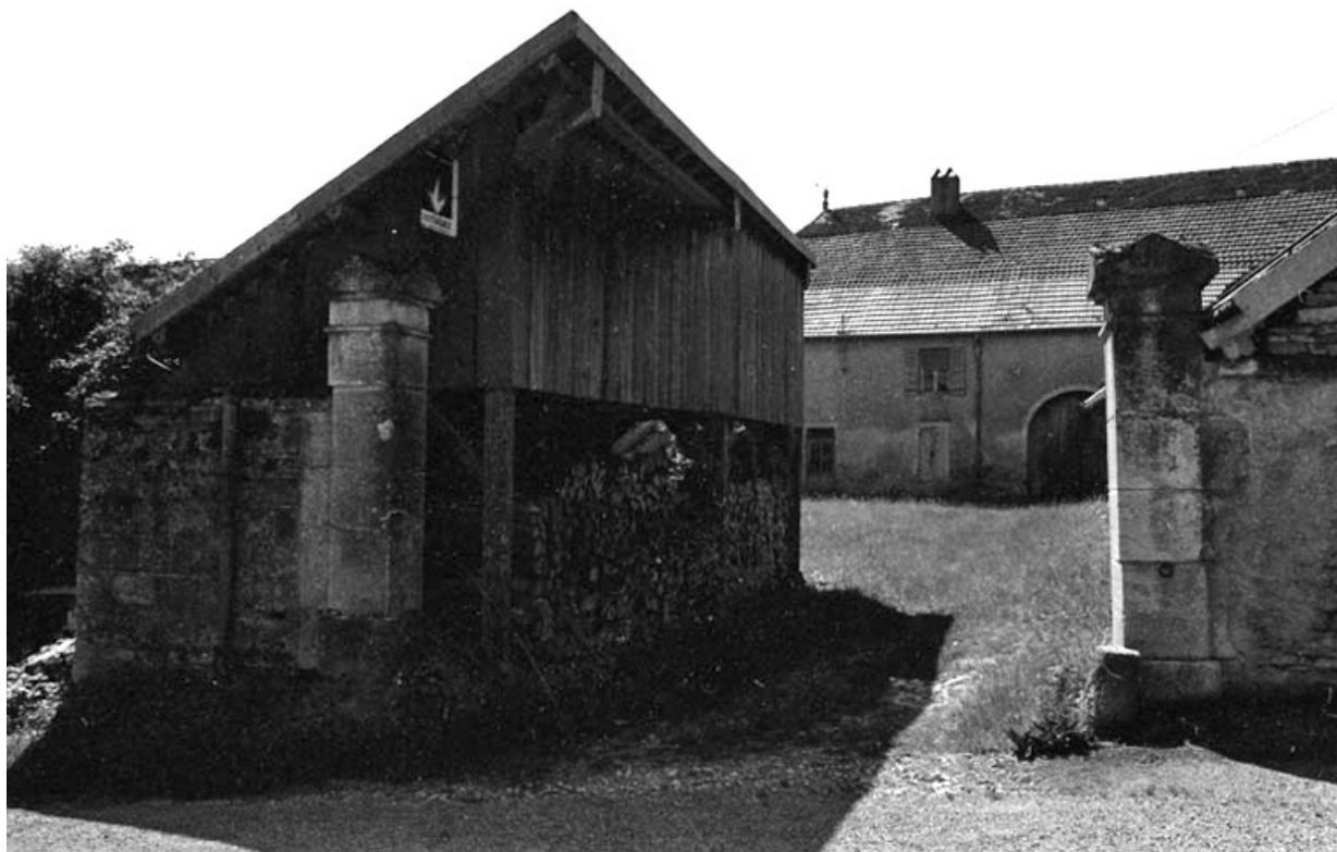
Vue depuis l'entrée de la cour.
