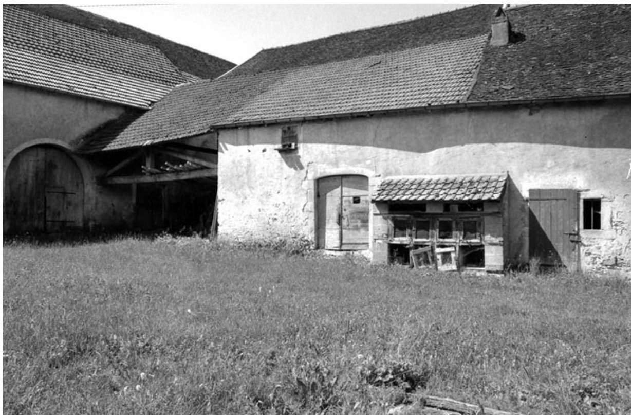
Détail : dépendances à droite dans la cour.
