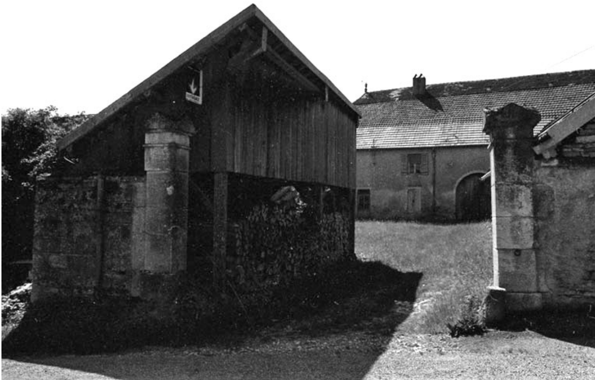
Vue depuis l'entrée de la cour.
