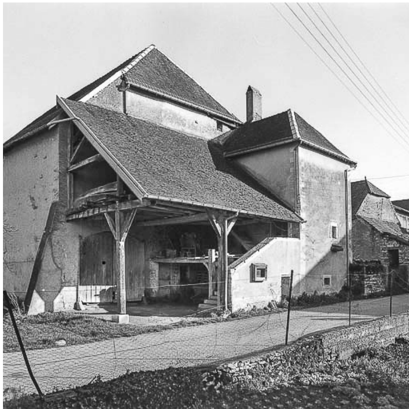
Détail : auvent et escalier extérieurs en 1984.
