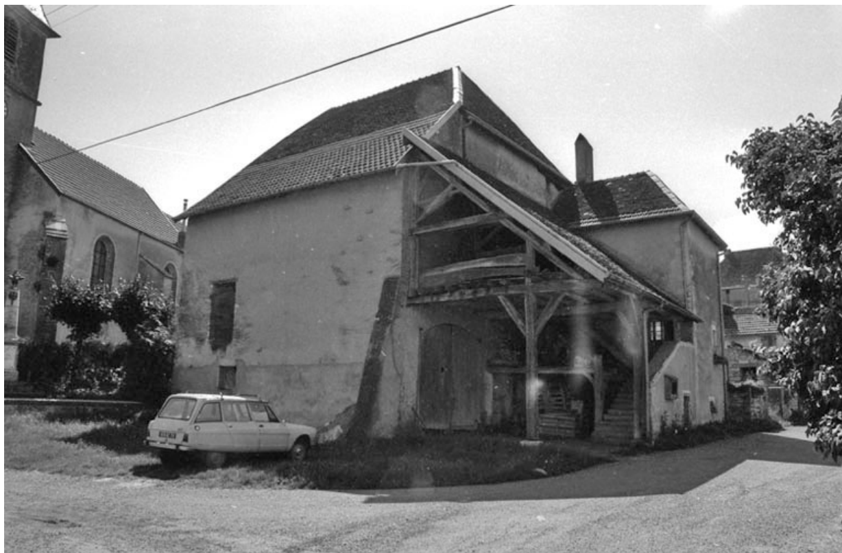
Vue d'ensemble depuis la Grande Rue en 1981.
