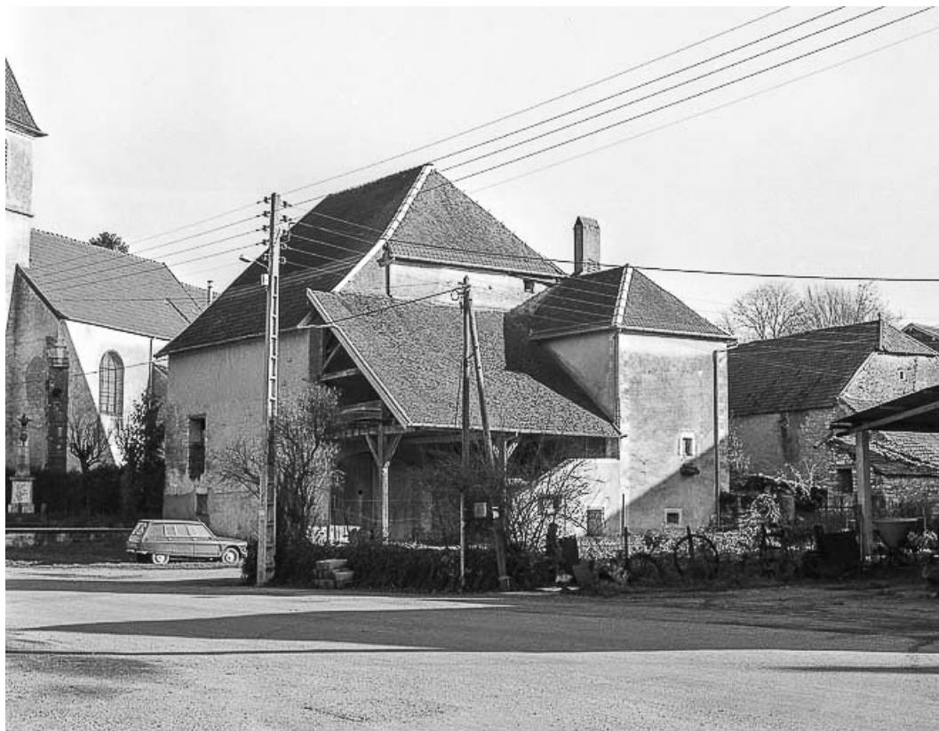
Vue d'ensemble depuis la Grande Rue en 1984.
