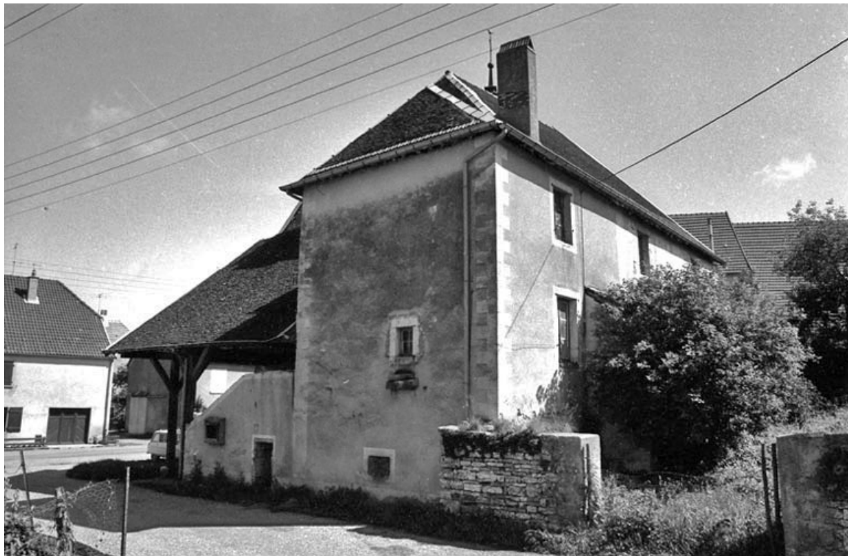
Façade postérieure en 1981.
