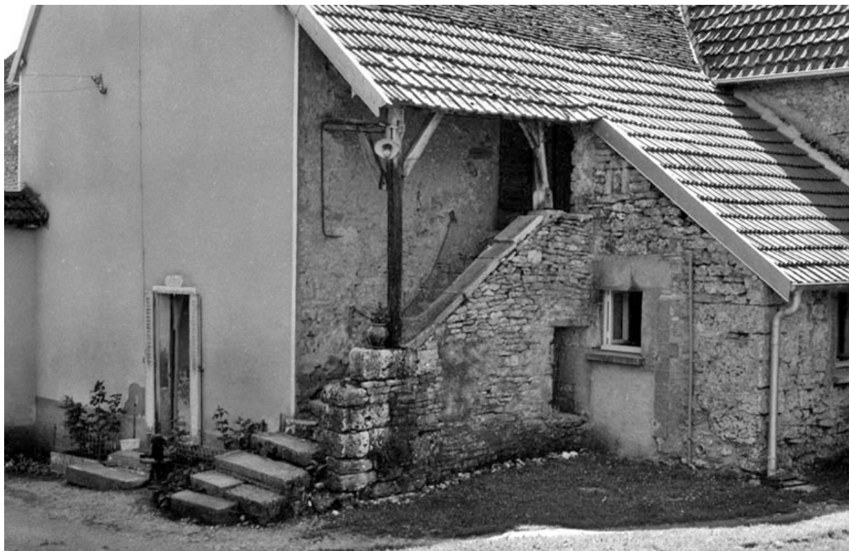
Ferme cadastrée 1939 A3 565, située Grande Rue : Habitation : détail de l'escalier extérieur. 70, Venère
