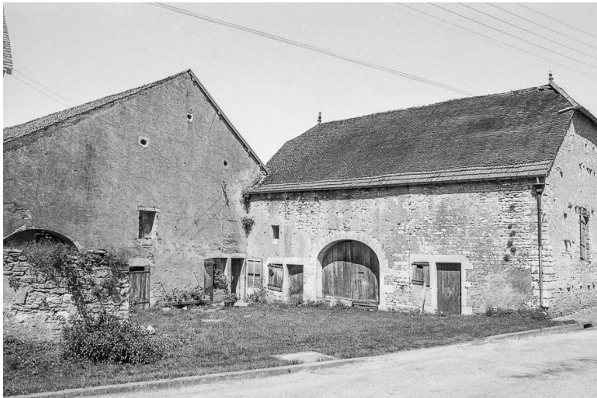
Vue de trois quarts droit du bâtiment.
