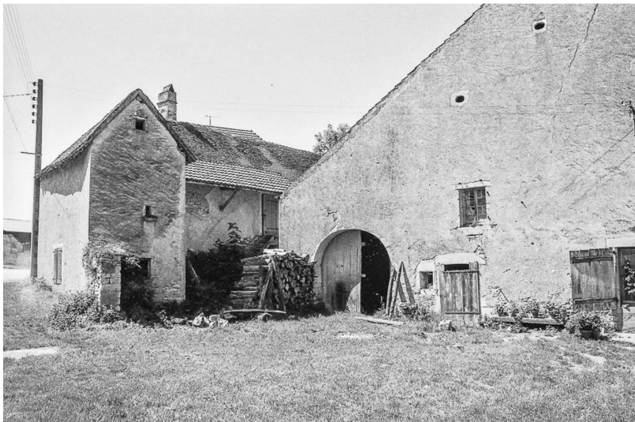
Vue de trois quarts gauche du bâtiment.
