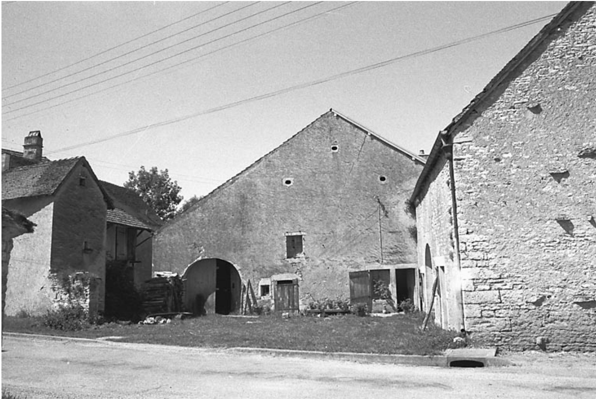
Vue du bâtiment principal de face depuis la rue. 70, Valay rue Fénelon
