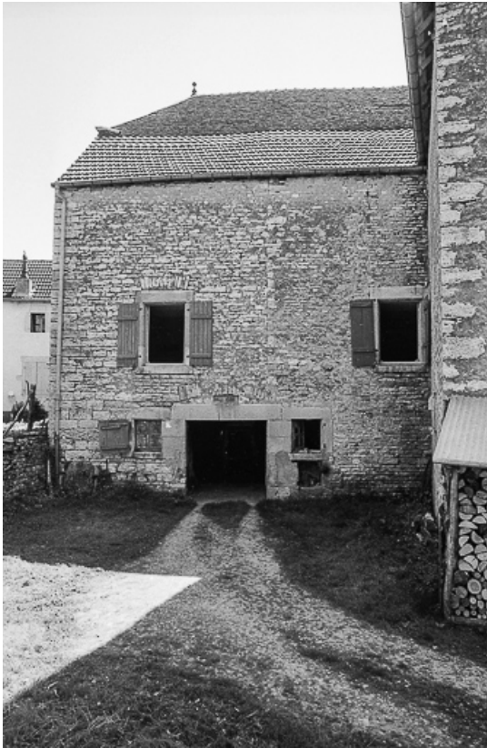
Détail : façade postérieure du bâtiment, habitation sur écurie. 70, Valay rue de l' Abreuvoir
