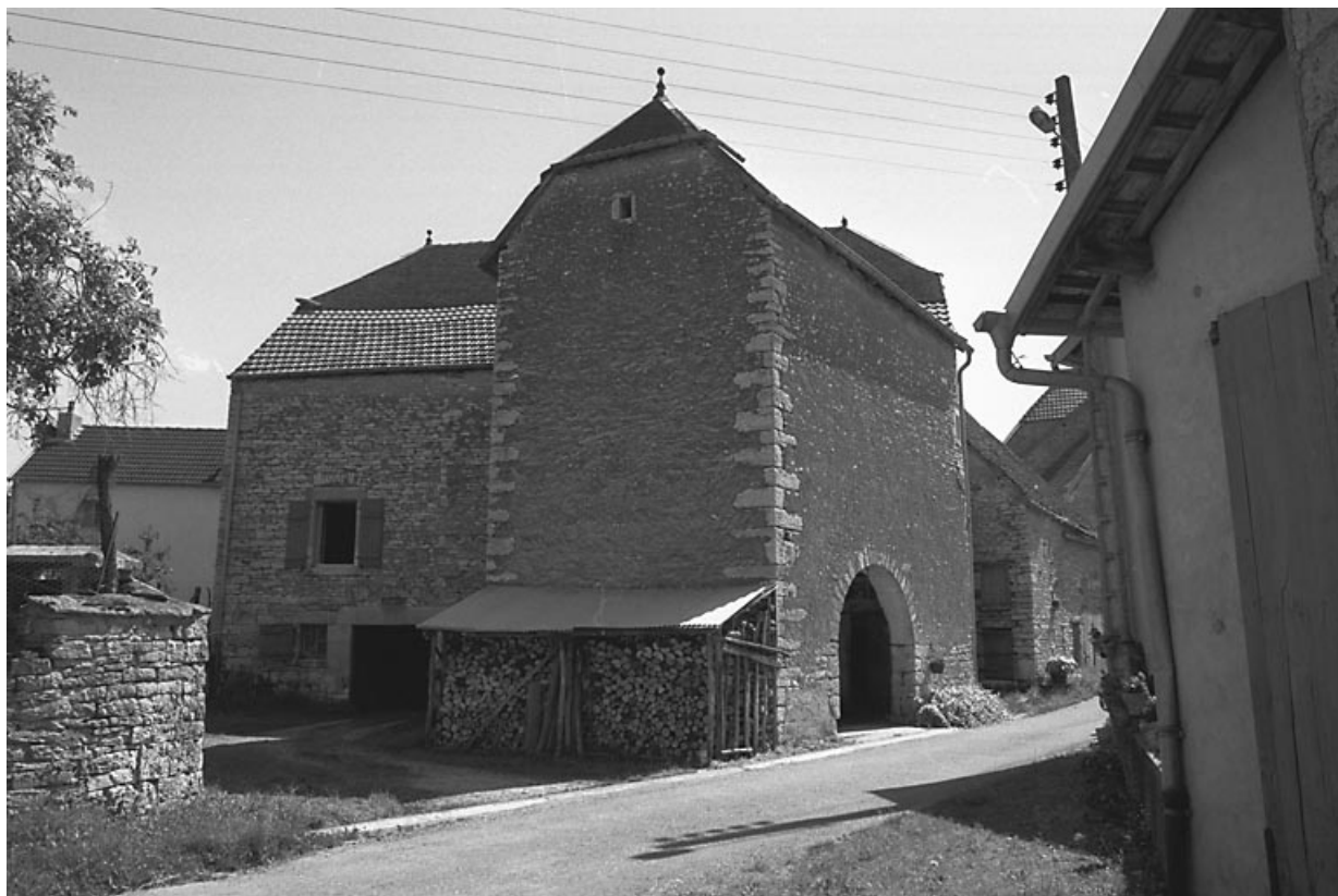
Façade postérieure du bâtiment.
