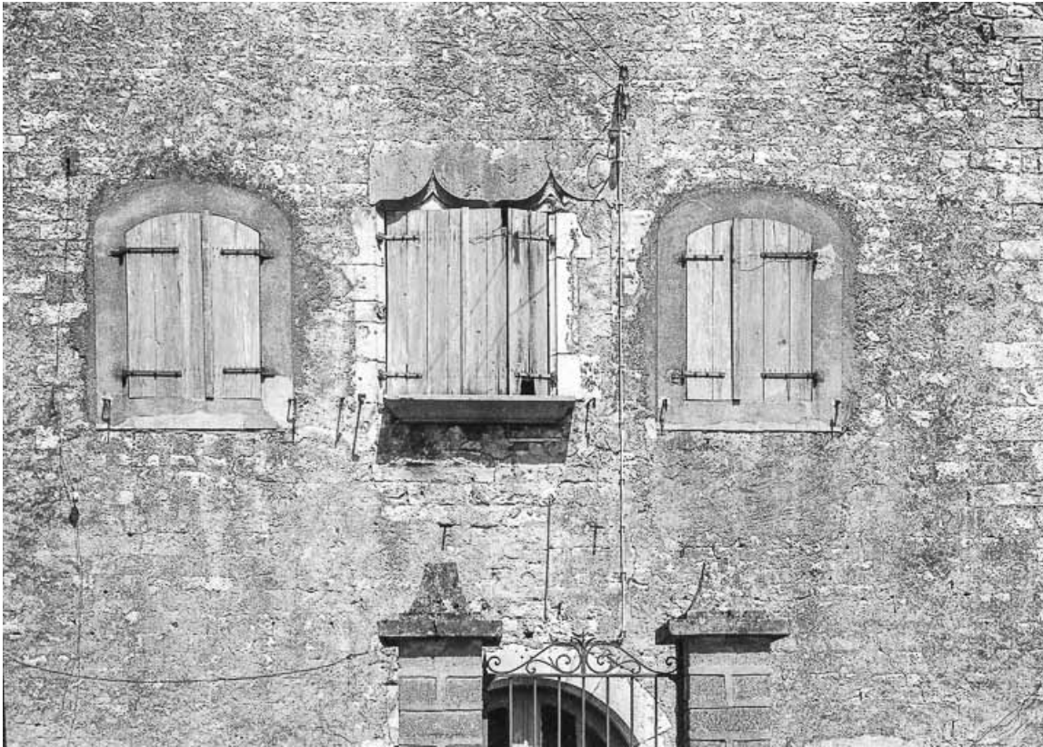
Mur en moellons calcaires recouverts d'enduit
