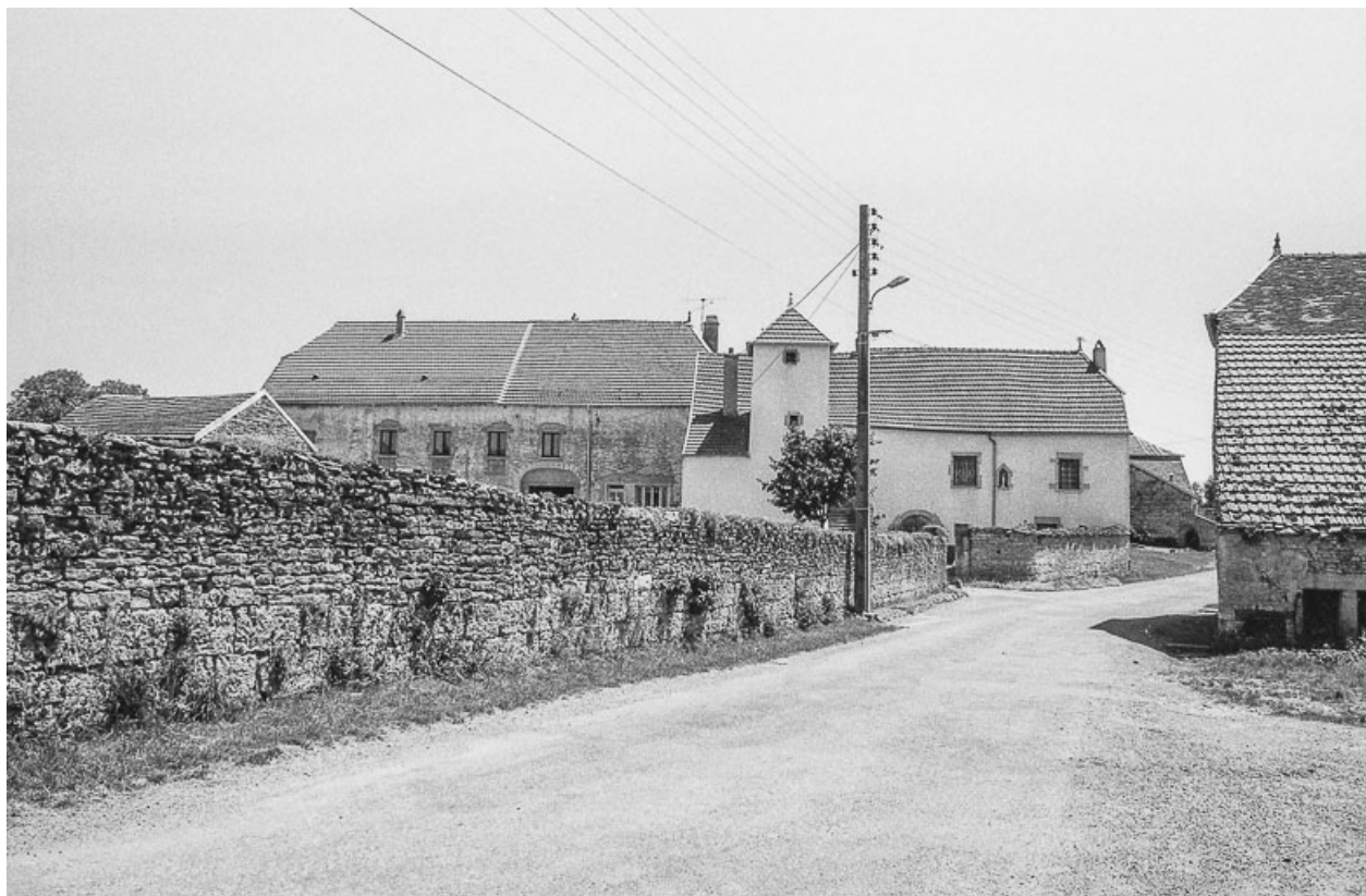
Vue éloignée du bâtiment depuis la rue.
