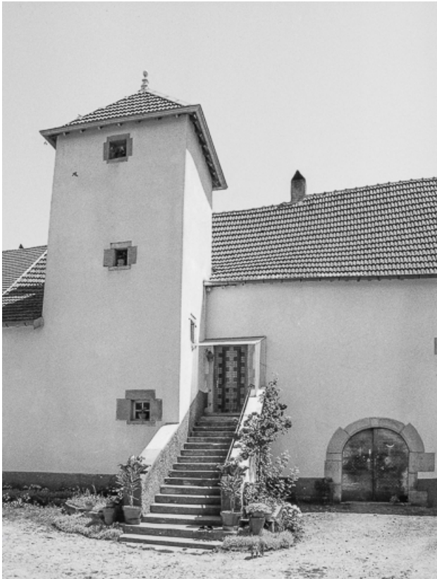
Détail : tour d'escalier et entrée de l'habitation.
