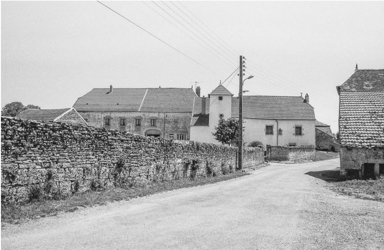
Vue éloignée du bâtiment depuis la rue.
