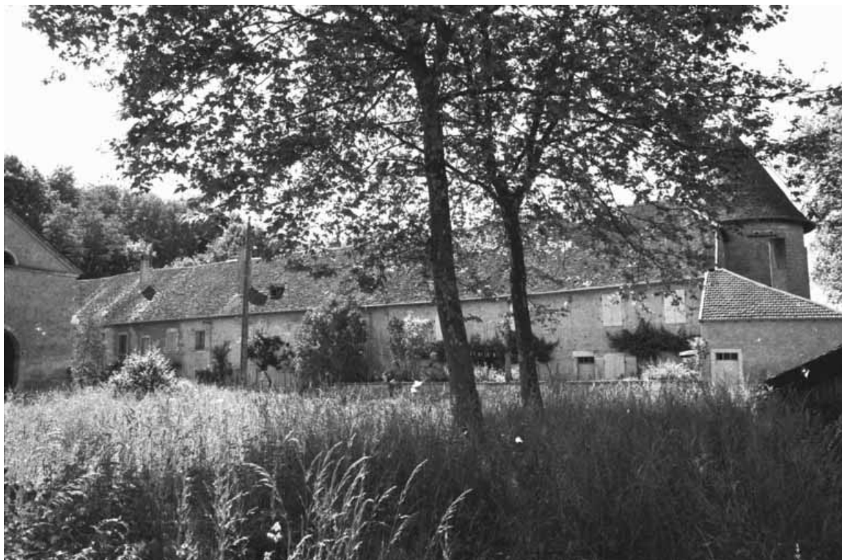
Vue d'ensemble du logement ouvrier en 1981.
