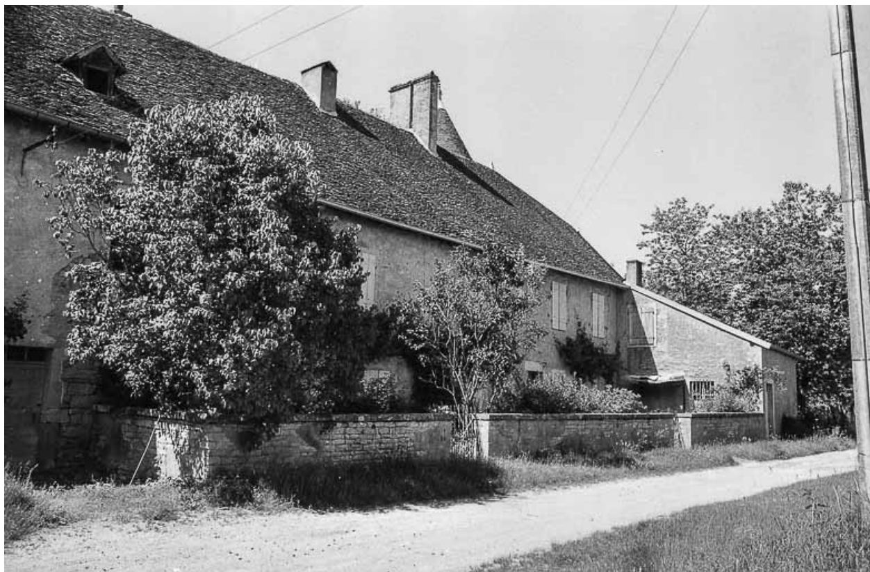
Façade sur cour du logement ouvrier. Vue de trois quarts gauche en 1981.
