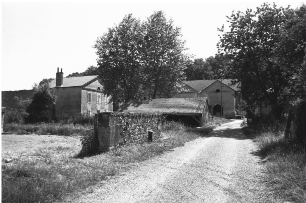
Vue d'ensemble depuis le chemin d'accès en 1981.
