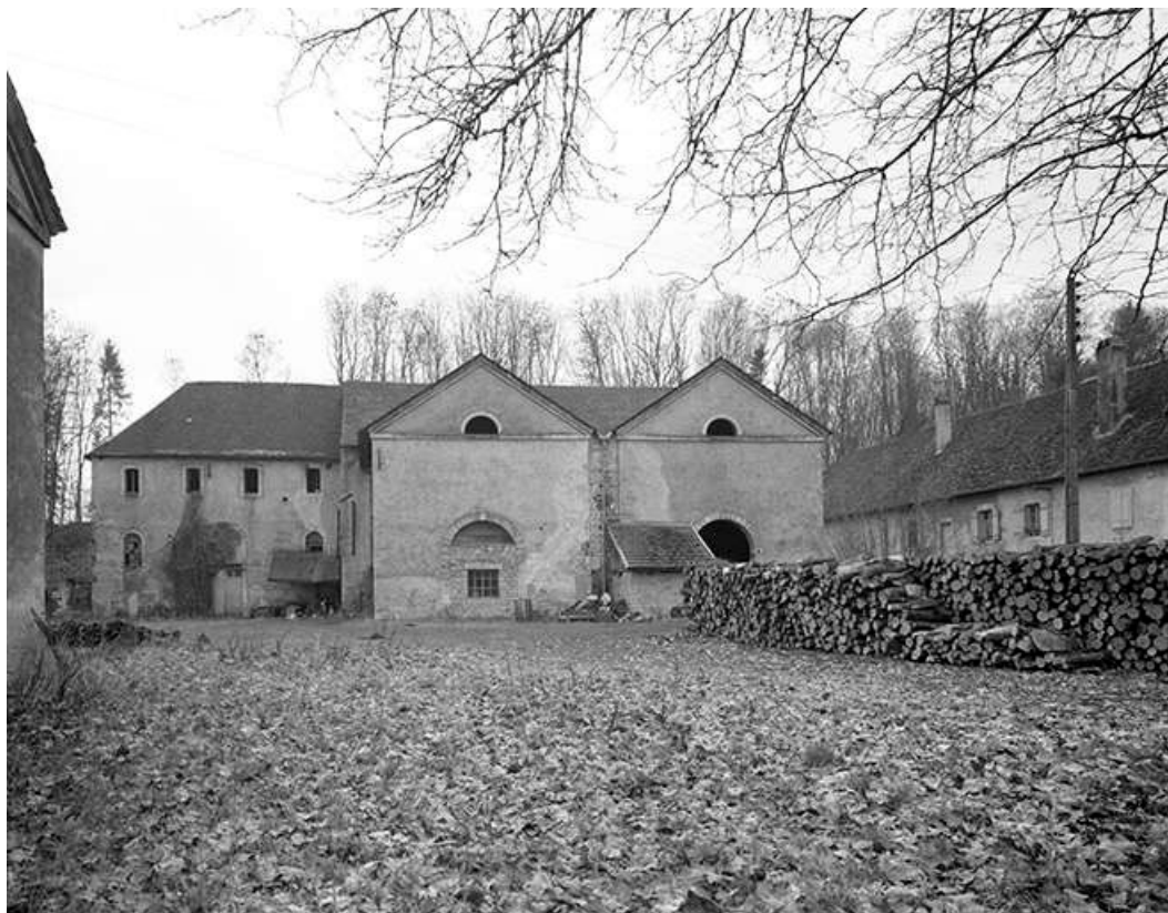
Le haut-fourneau vue de face en 1985.
