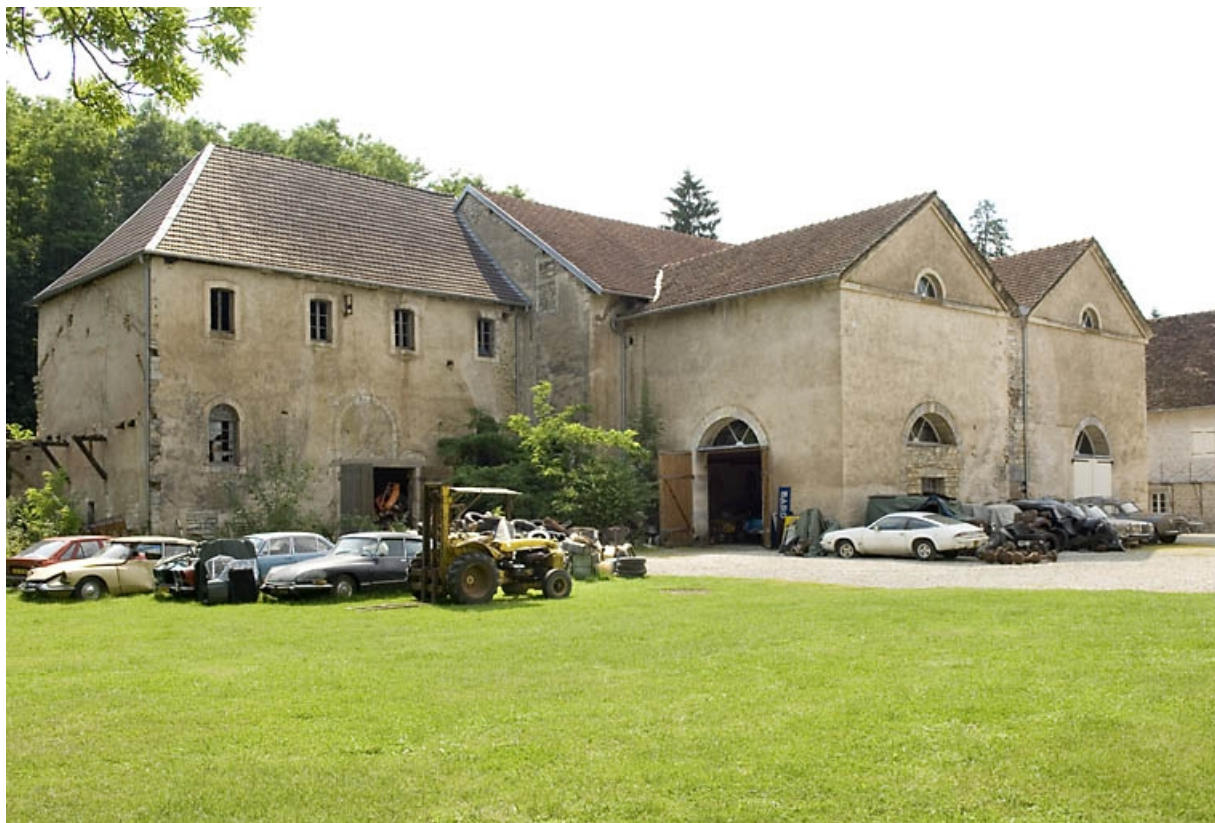
Vue d'ensemble du haut fourneau depuis l'est en 2008.
