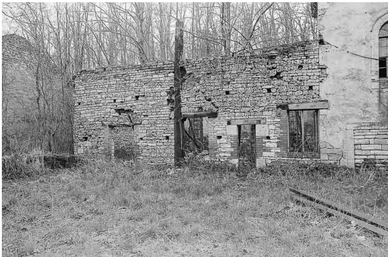
Vestiges des magasins sur le mur d'enceinte sud en 1979.
