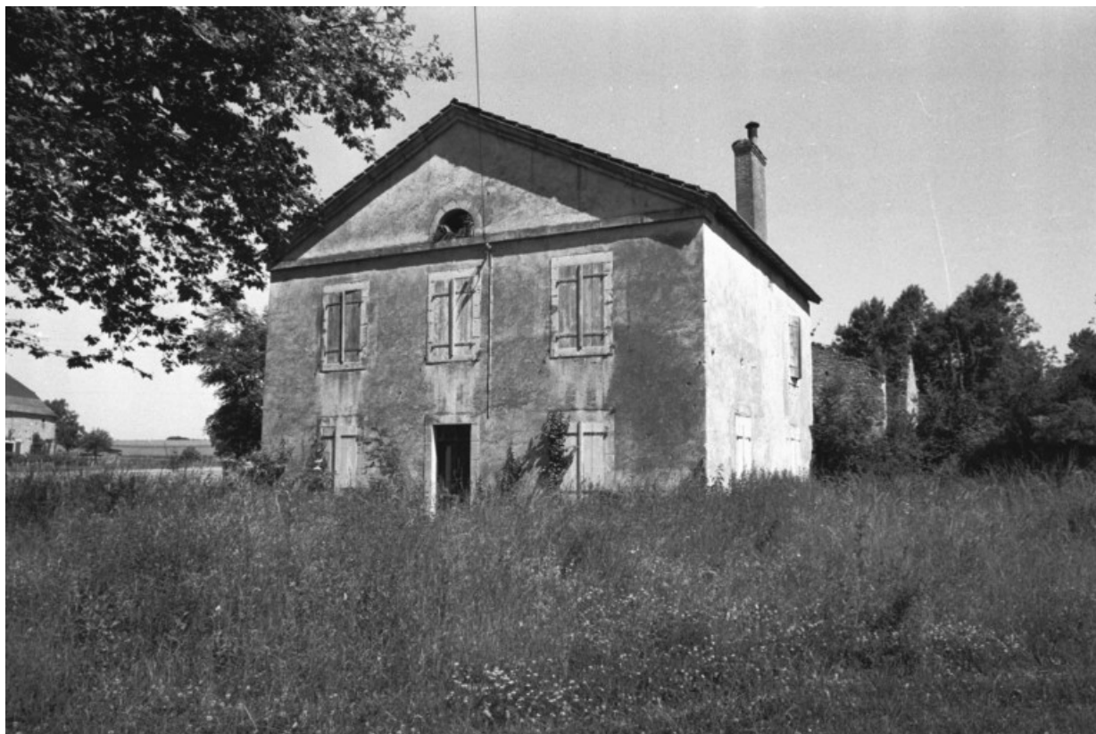
Logement patronal. Vue de trois quarts en 1981.
