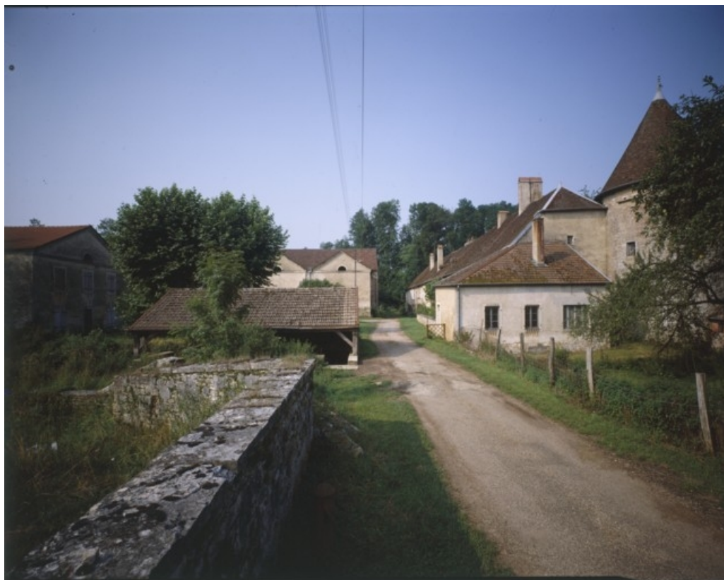
Vue d'ensemble depuis le chemin d'accès en 1989.
