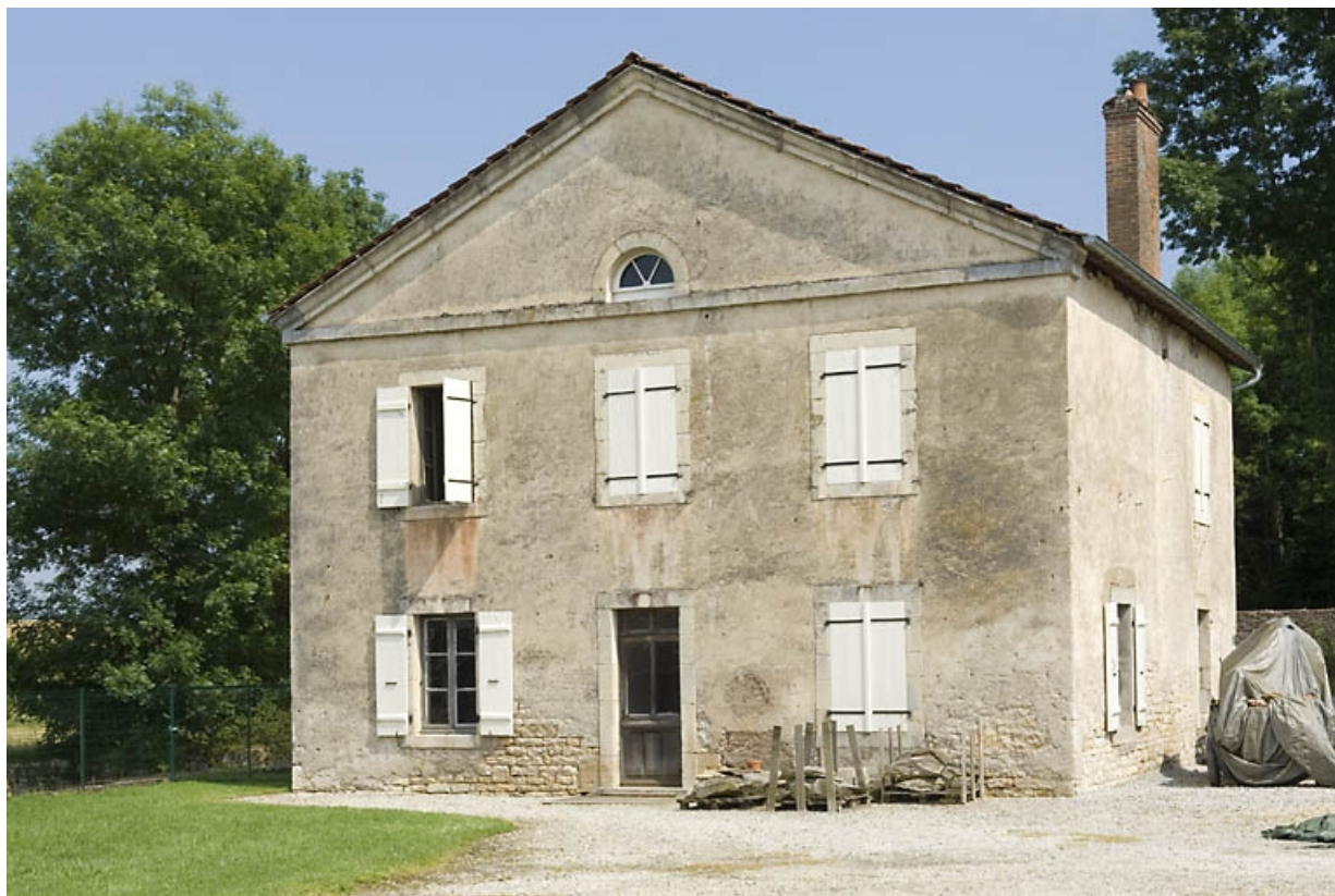
Logement patronal vu de face en 2008.
