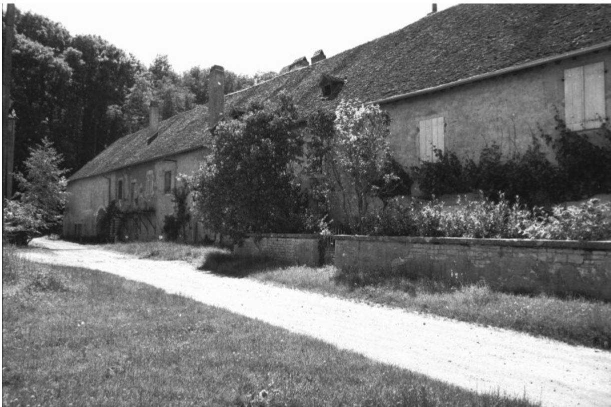
Façade du logement ouvrier : vue de trois quarts droit en 1981.
