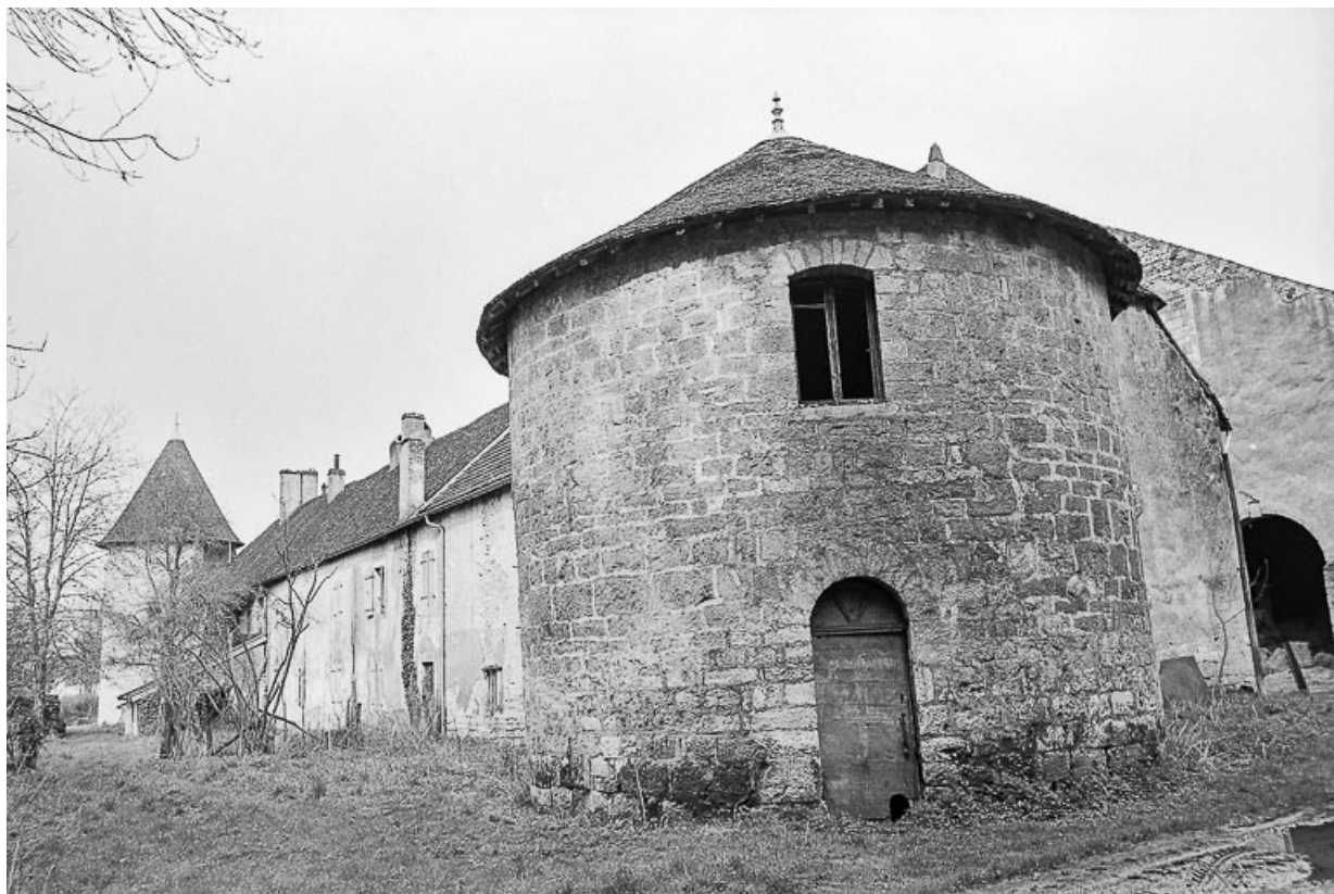
Tours d'enceinte et logement ouvrier depuis l'ouest en 1979.
