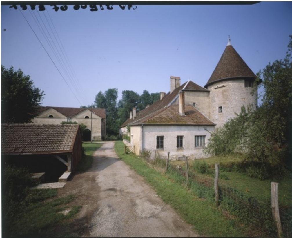
Vue d'ensemble depuis le chemin d'accès en 1989.
