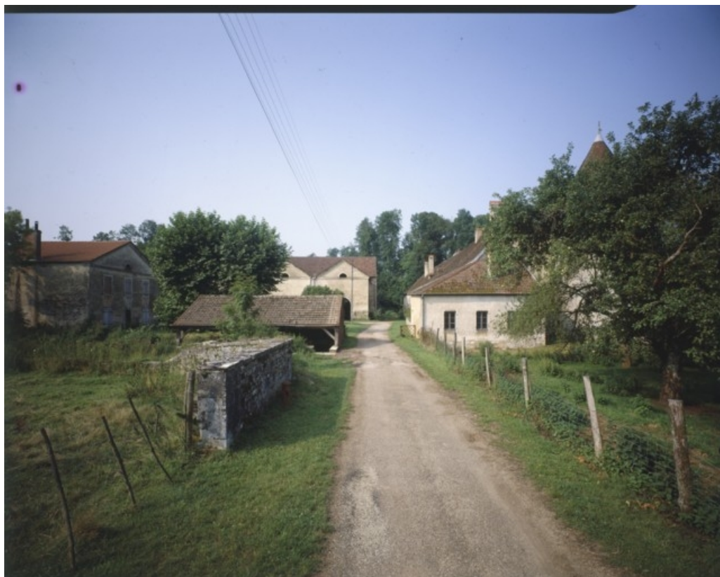
Vue d'ensemble depuis le chemin d'accès en 1989. 70, Valay, 9 rue du Vieux Château, lieudit : Petit Valay
