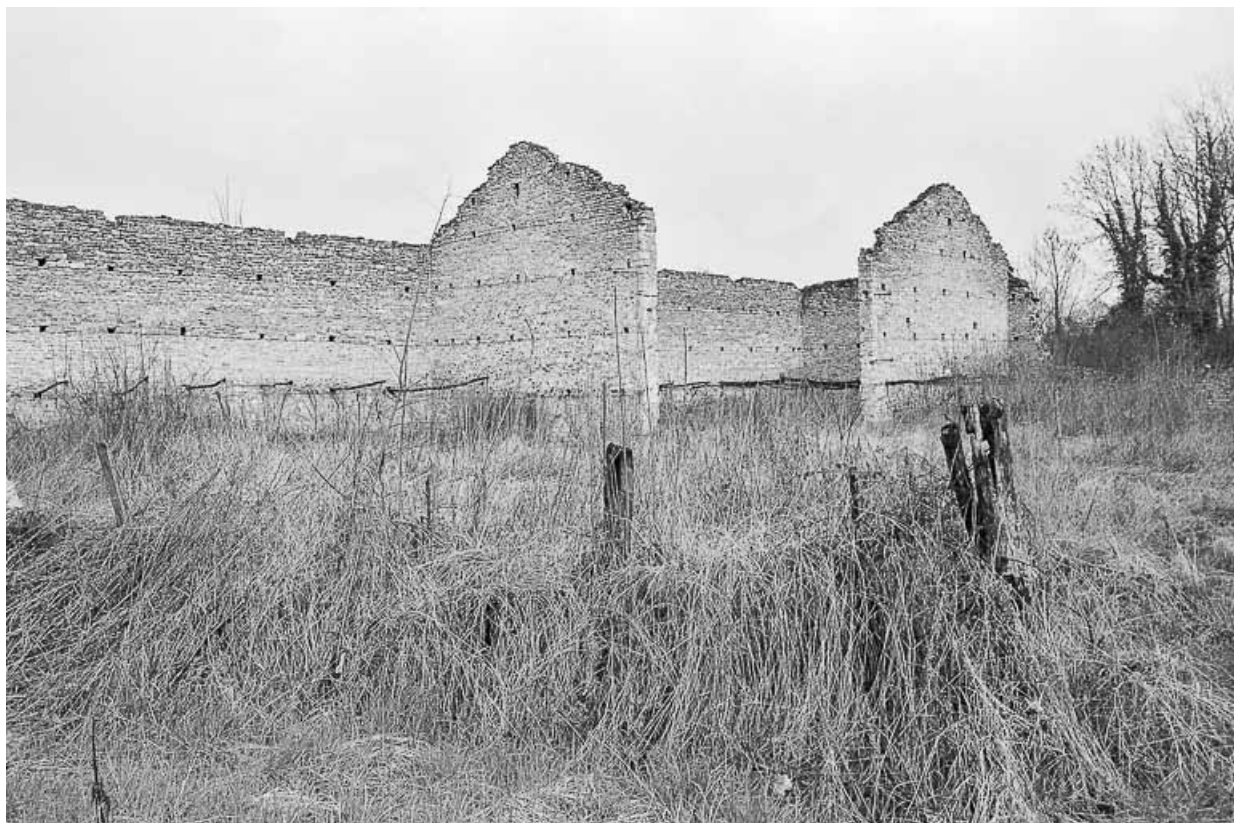
Vestiges des remises (?) sur le mur d'enceinte nord en 1979.
