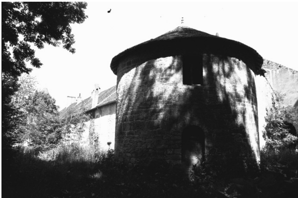
Tour d'enceinte ouest en 1981.
