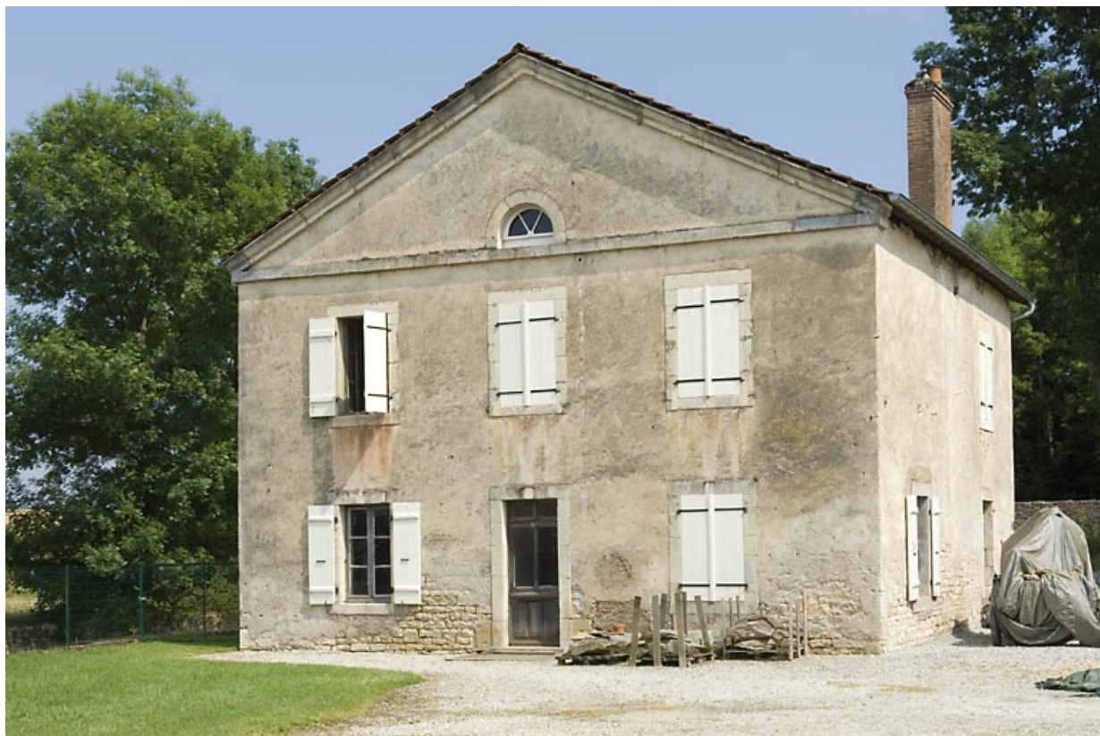
Logement patronal vu de face en 2008.
