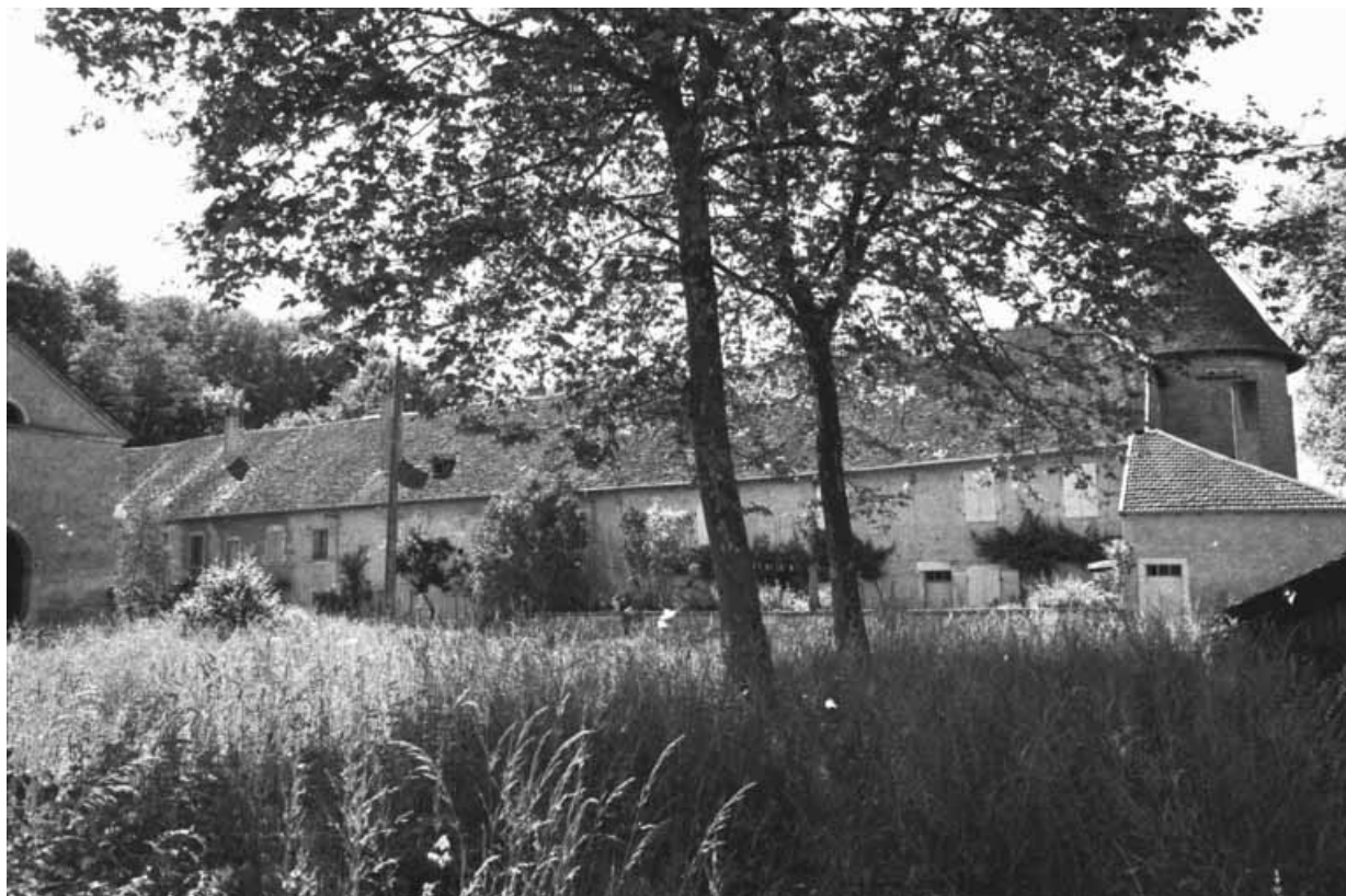
Vue d'ensemble du logement ouvrier en 1981.
