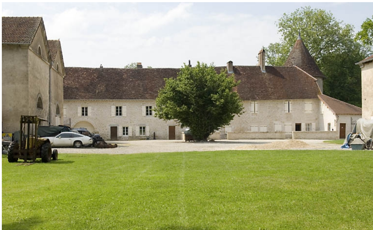
Logement ouvrier : vue d'ensemble depuis le sud-est en 2008.
