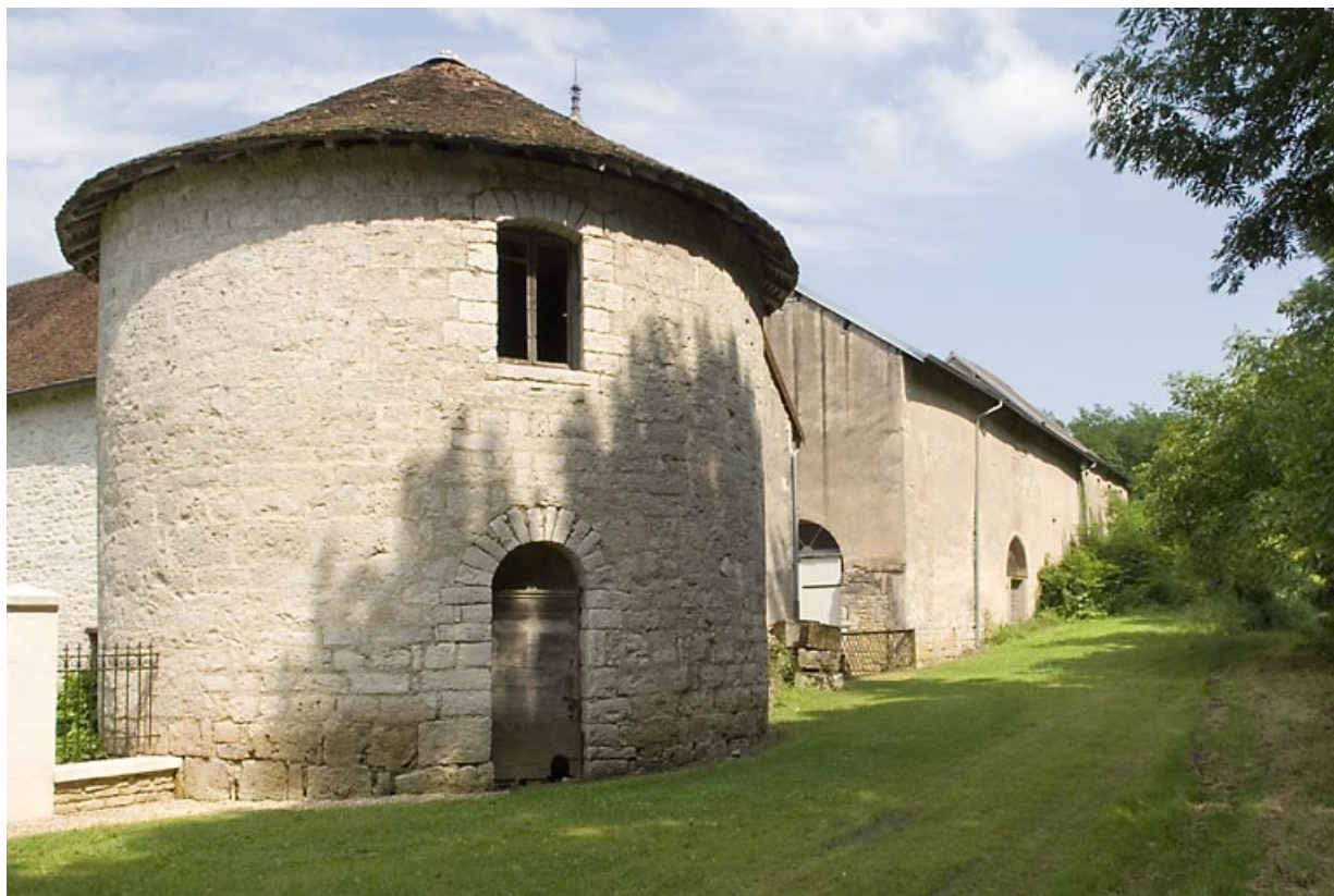
Tour d'enceinte et façade arrière du haut fourneau.
