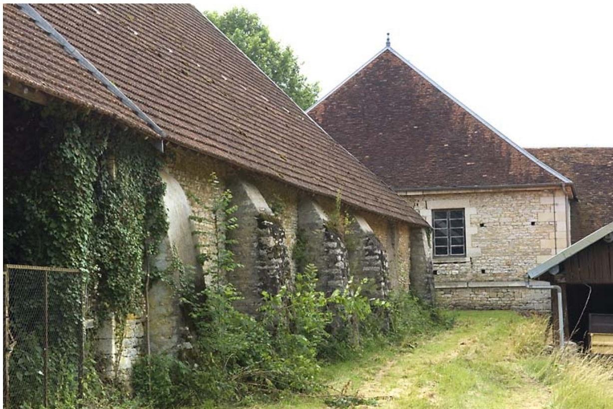
Contreforts du mur nord de la halle à charbon.
