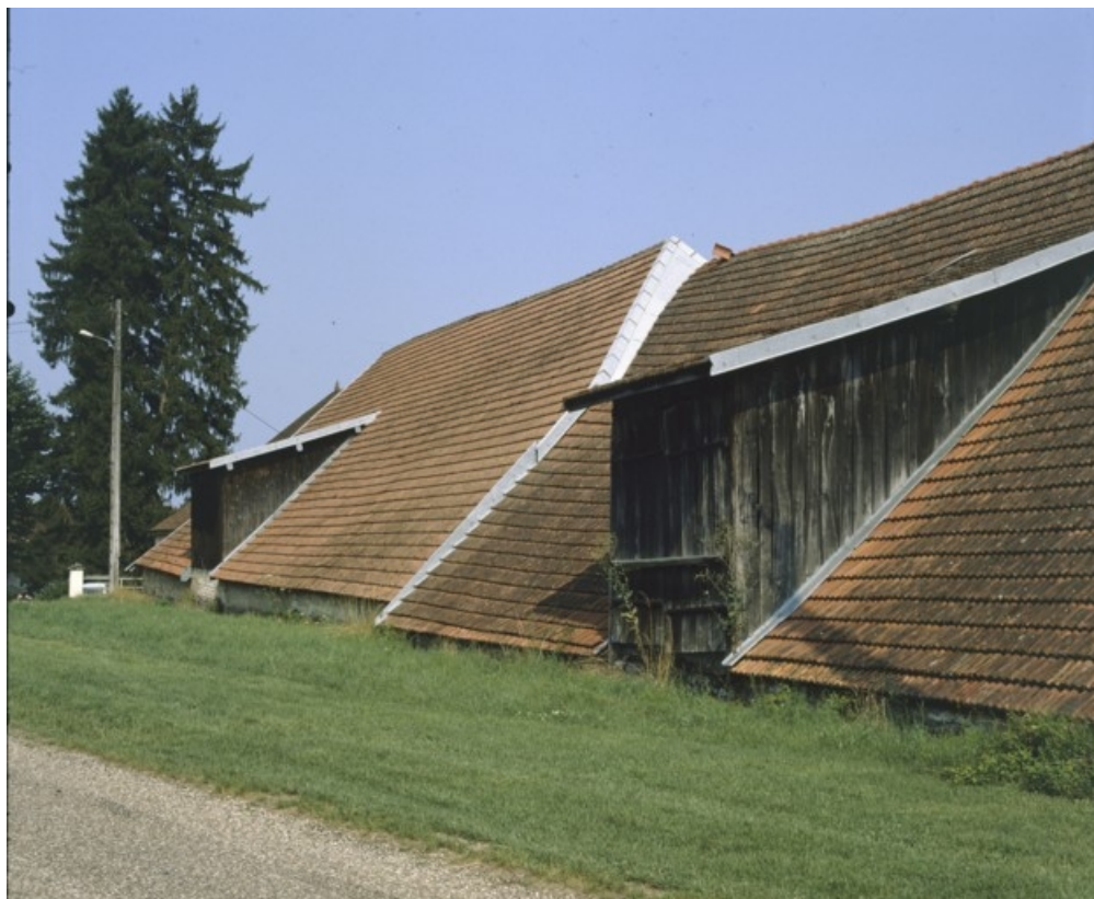
Toitures de la halle à charbon. Vue de trois quarts en 1989.
