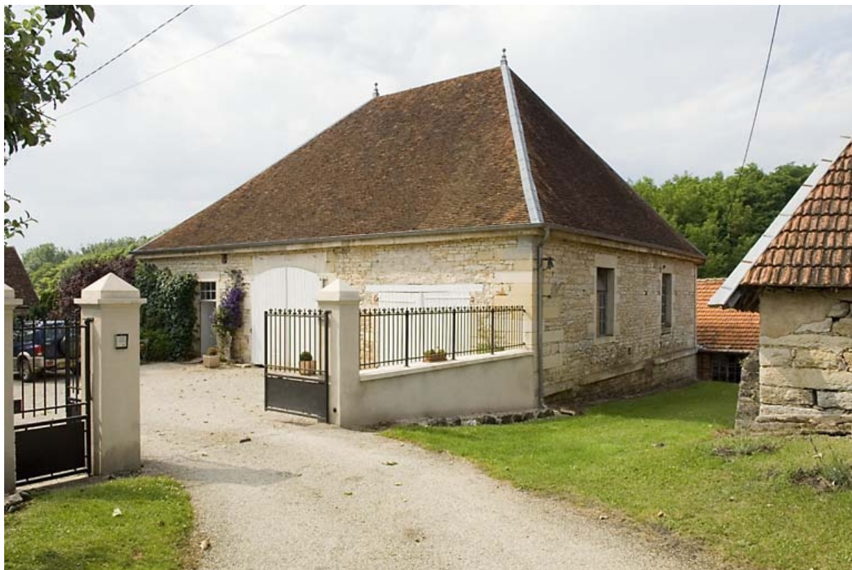
Le haut fourneau vu depuis le sud-est.
