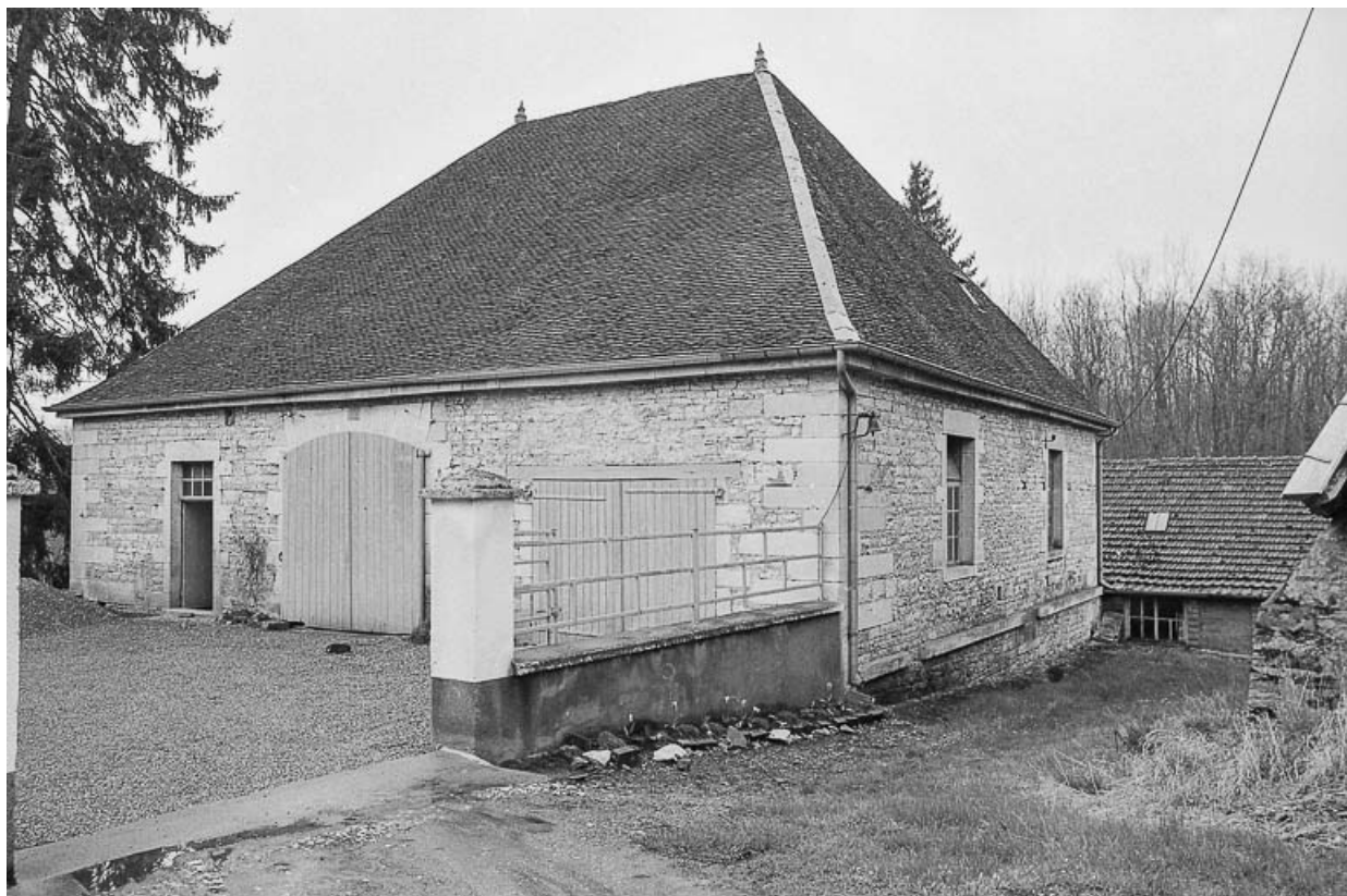
Bâtiment du haut fourneau vu de trois quarts en 1979.
