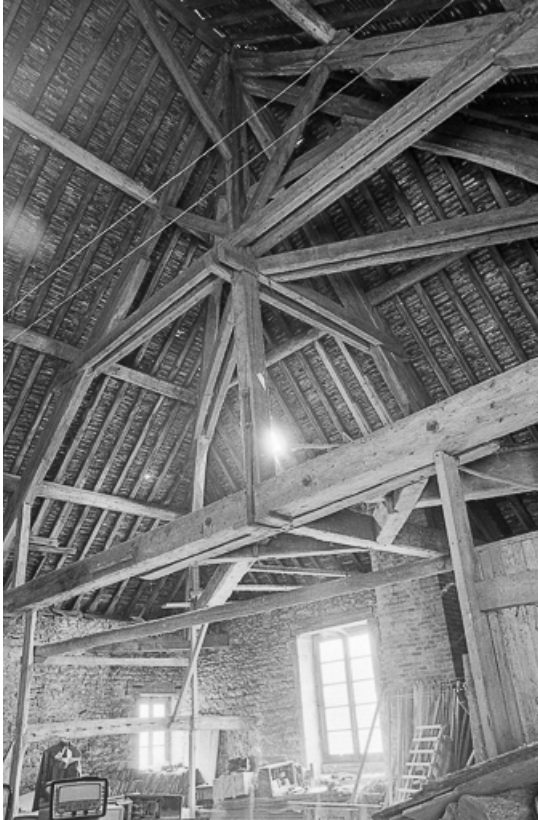
La charpente du haut fourneau en 1979.
