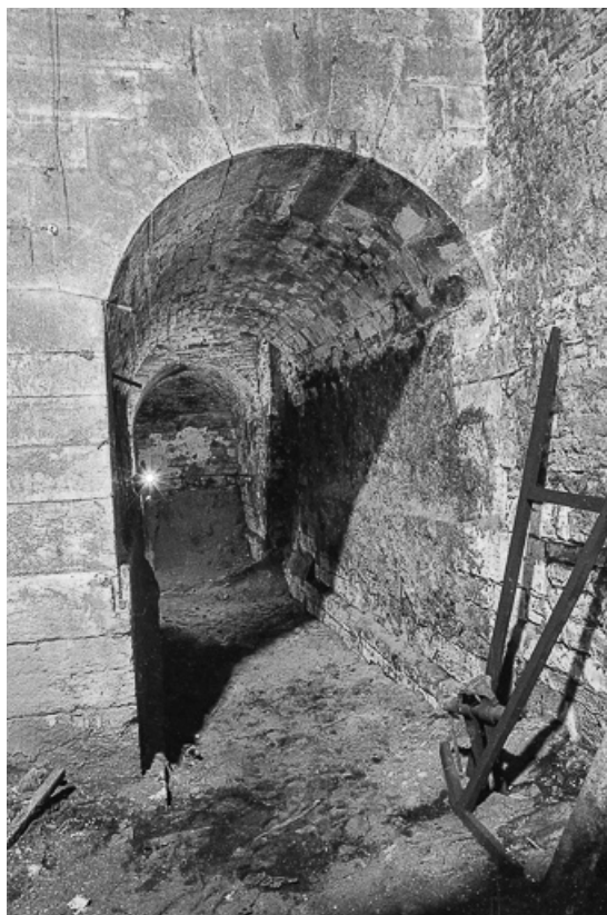
Base du haut fourneau en 1979. Galerie ouest. 70, Valay rue du Chatelard, lieudit : le Fourneau
