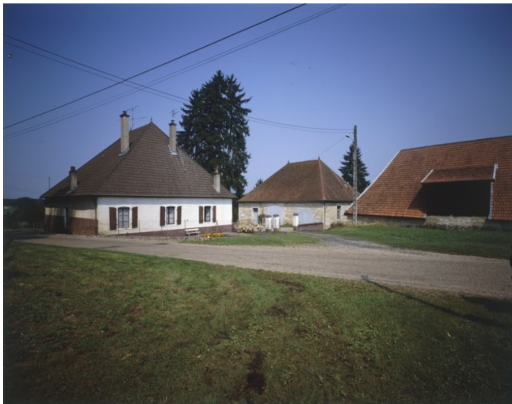
Logement patronal, bâtiment du haut fourneau et halle à charbon. Vue d'ensemble en 1989. 70, Valay rue du Chatelard, lieudit : le Fourneau
