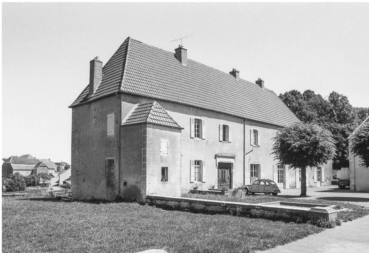
Façade antérieure du bâtiment principal.
