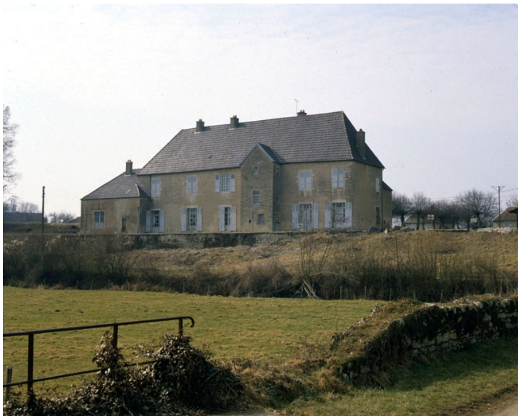
Façade postérieure, vue de trois quarts droit.
