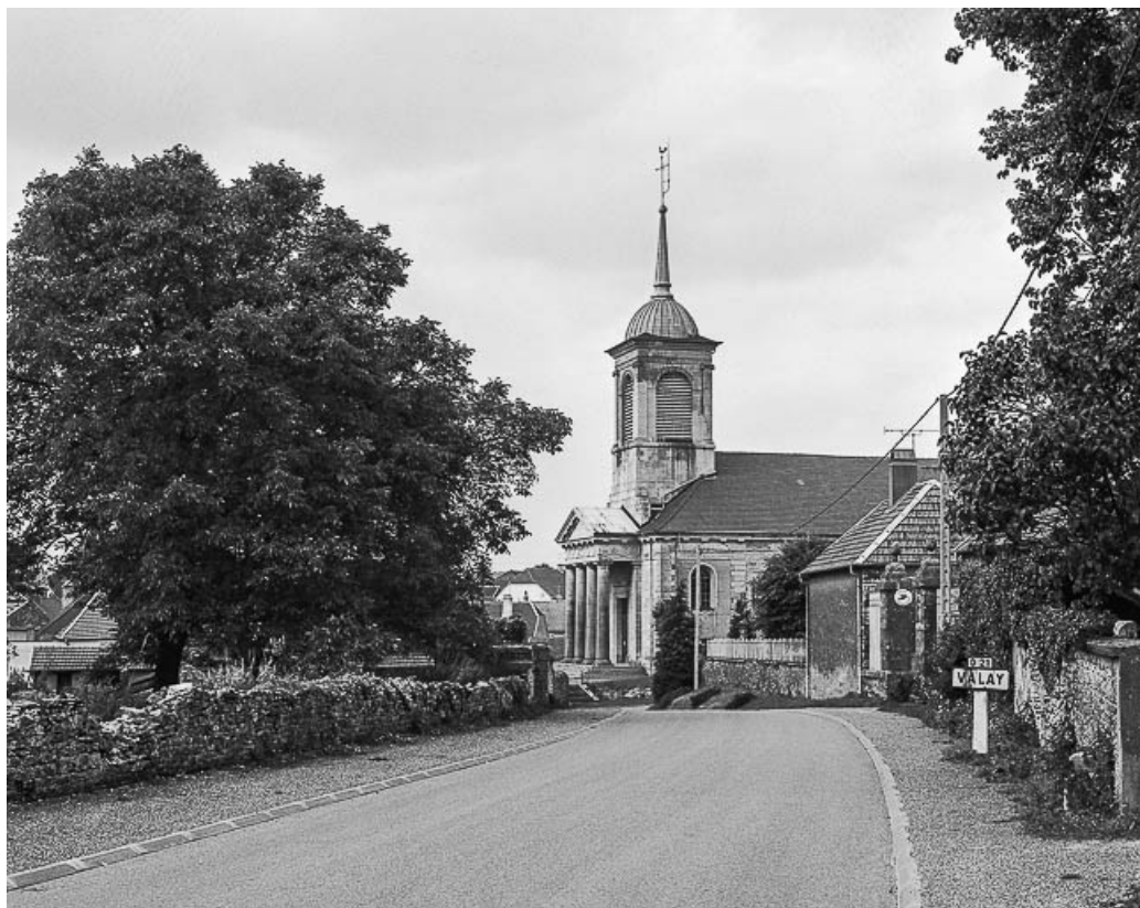
Façades antérieure et latérale droite.
