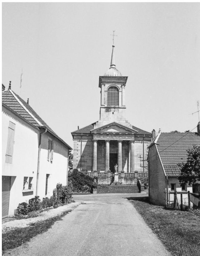
Façade antérieure vue de face.
