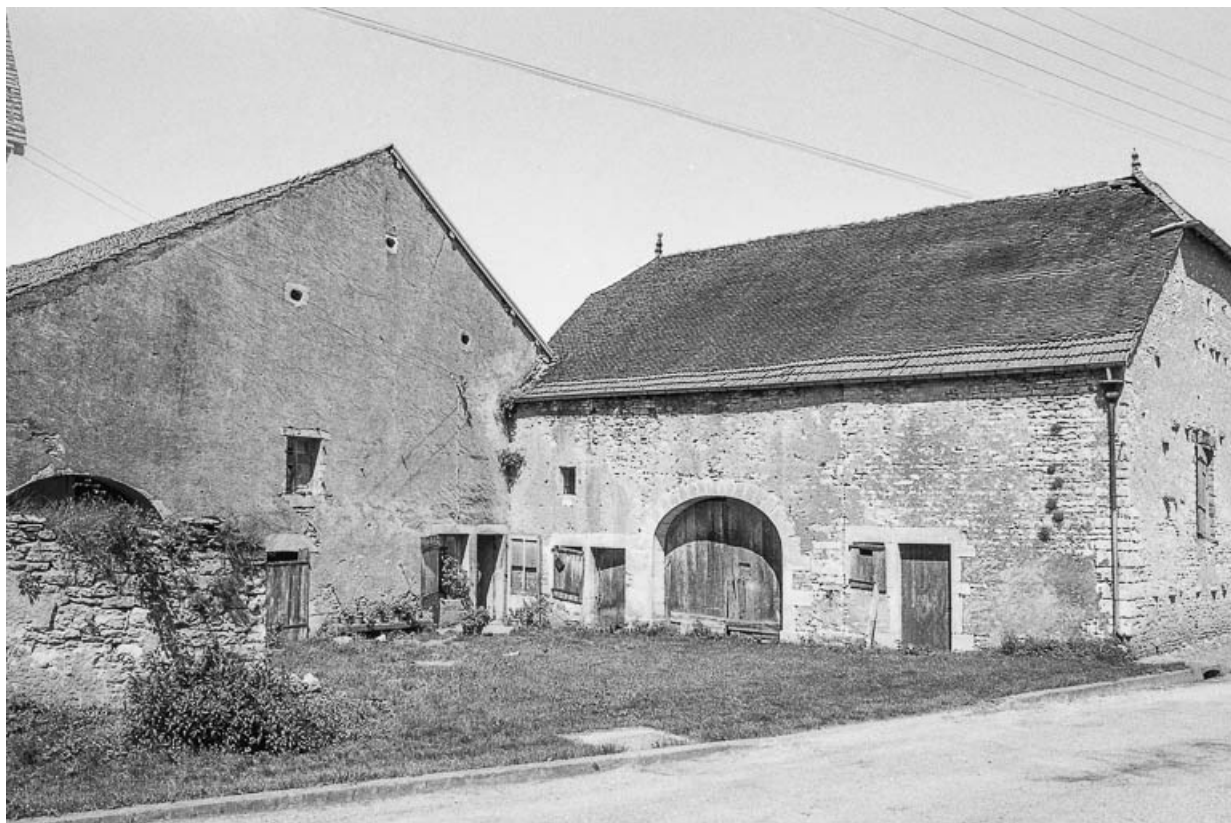
Vue de trois quarts droit du bâtiment.
