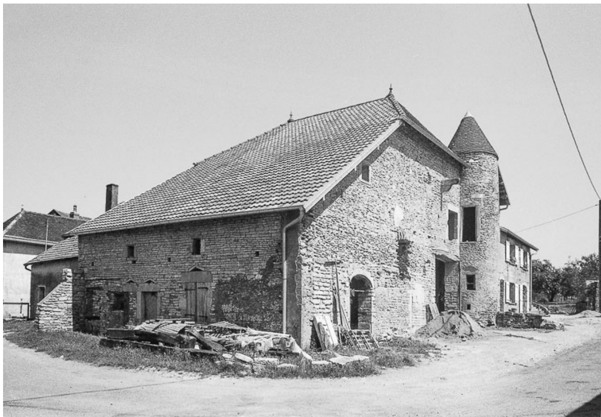
Maison cadastrée 1980 C1 134, située rue du Château d'eau : façades antérieure et latérale droite. 70, Valay
