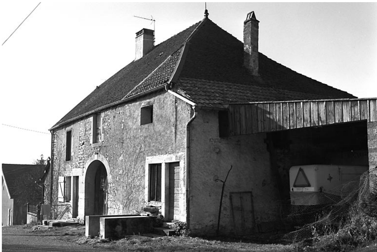
Vue d'ensemble de trois quarts droit. 70, Valay
