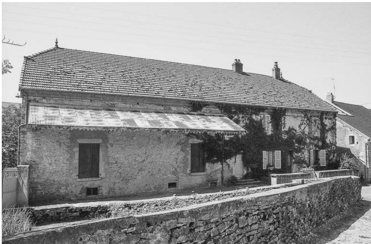
Maison cadastrée 1980 C1 208 : façade antérieure. 70, Valay
