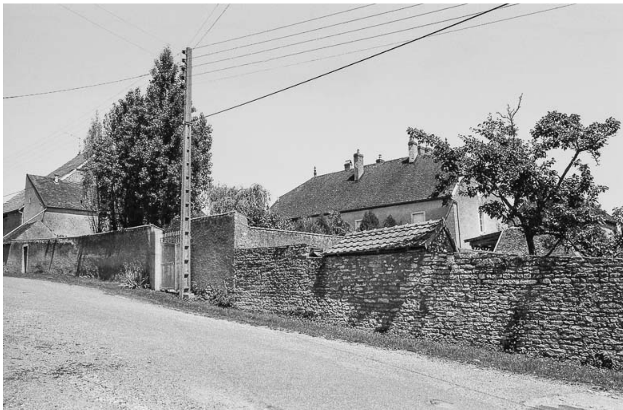
Maison cadastrée 1980 C1 1335 : vue d'ensemble. 70, Valay
