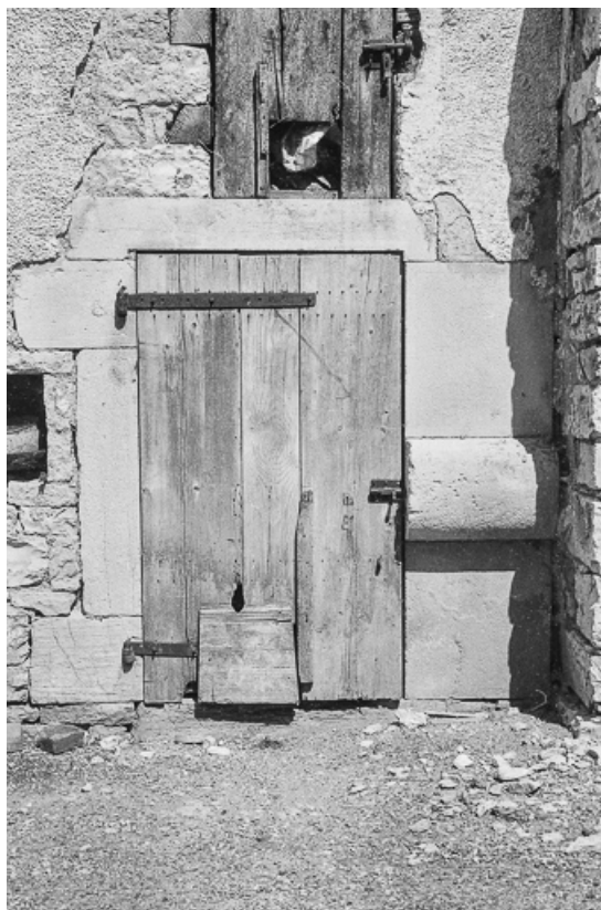
Ferme cadastrée 1980 C1 134, située rue du Château d'eau : porte de la porcherie. 70, Valay
