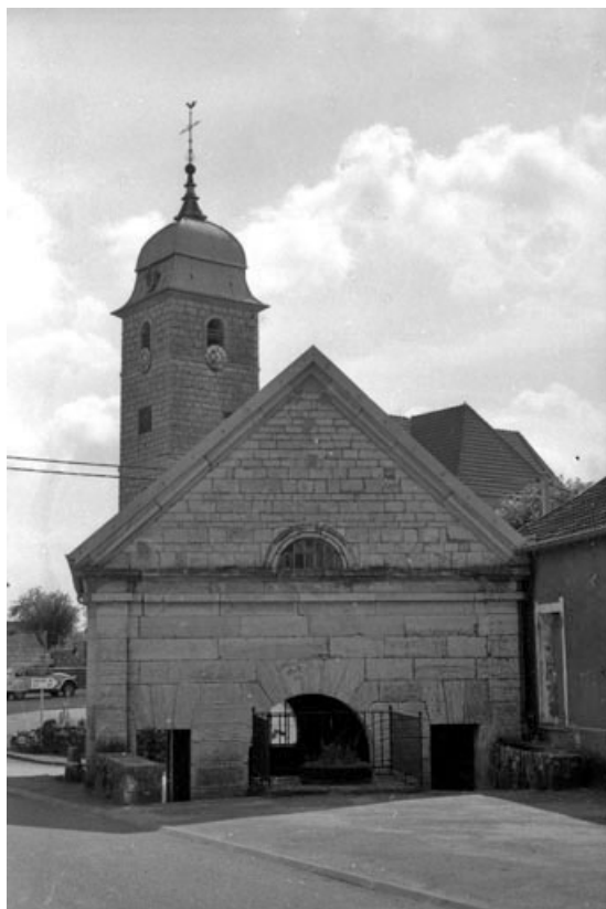
Façade sur pignon depuis la rue Haute. 70, Vadans rue Haute
