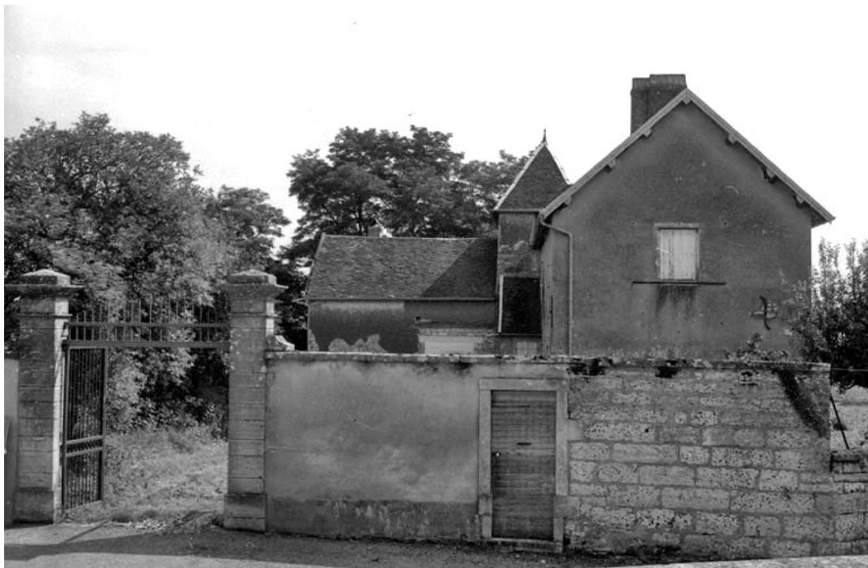
Vue d'ensemble depuis le portail.
