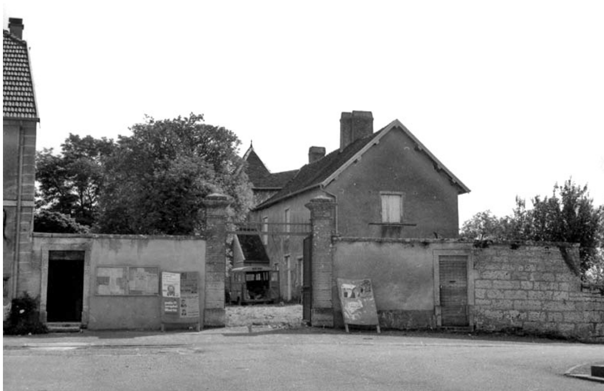
Vue d'ensemble depuis le portail.
