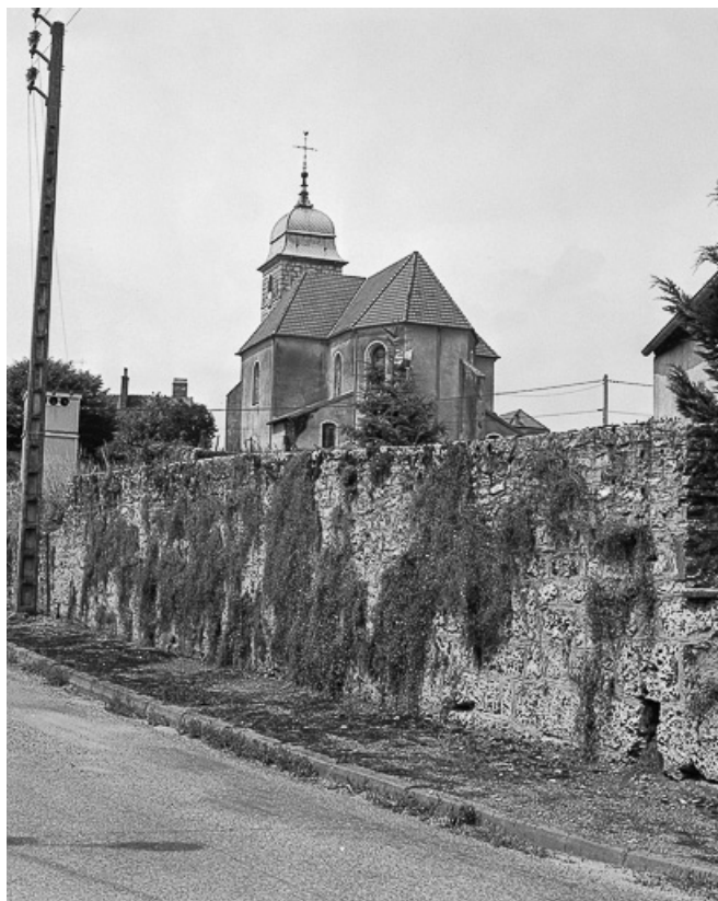
Chevet et façade latérale droite.
