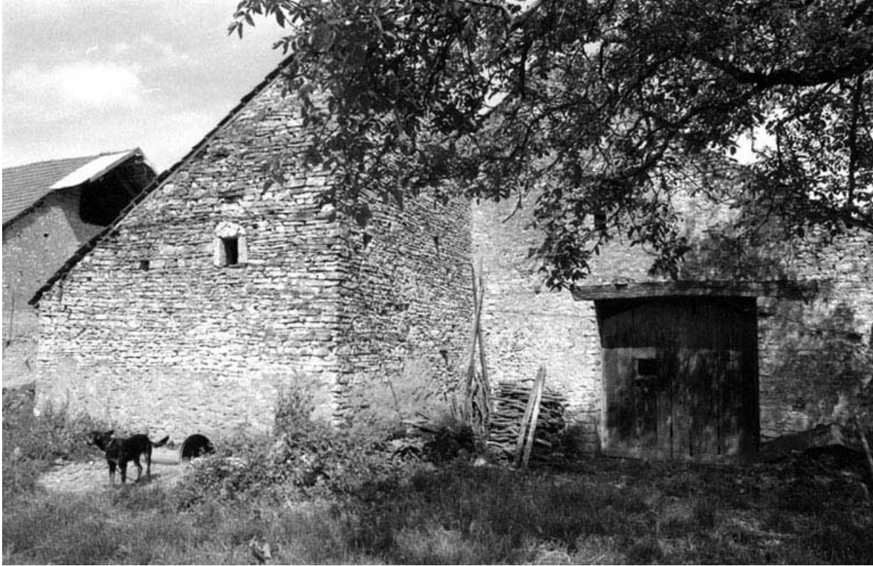
Remise et four : façade sur rue. 70, Vadans rue Gazelle
