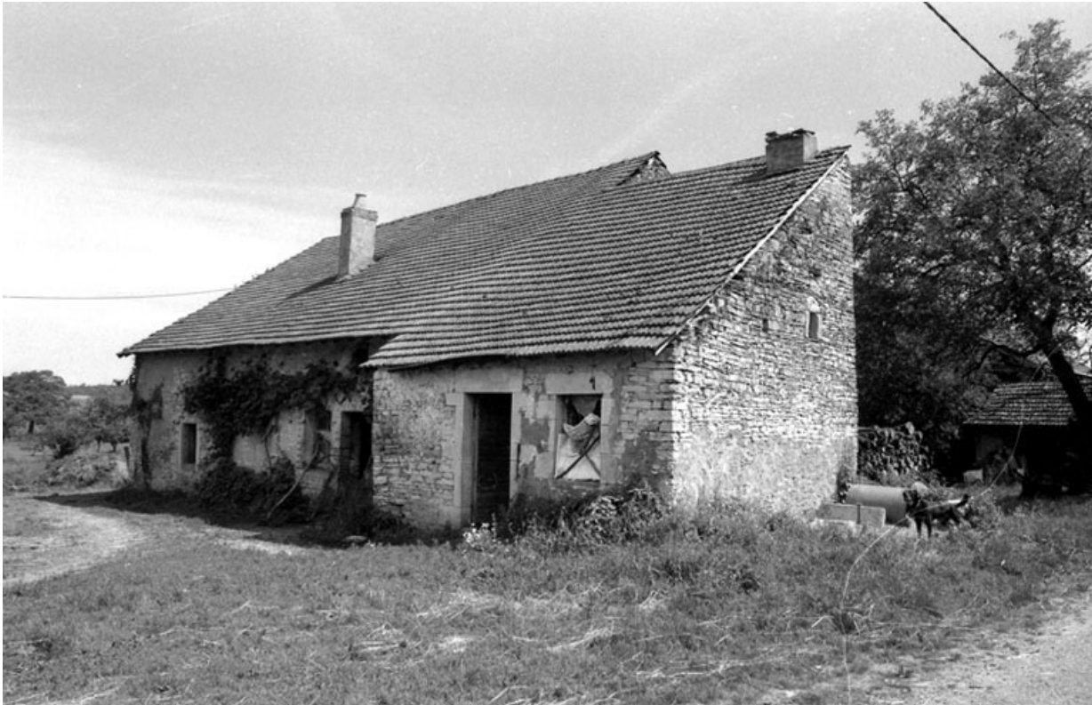
Bâtiment annexe dans la cour. 70, Vadans rue Gazelle
