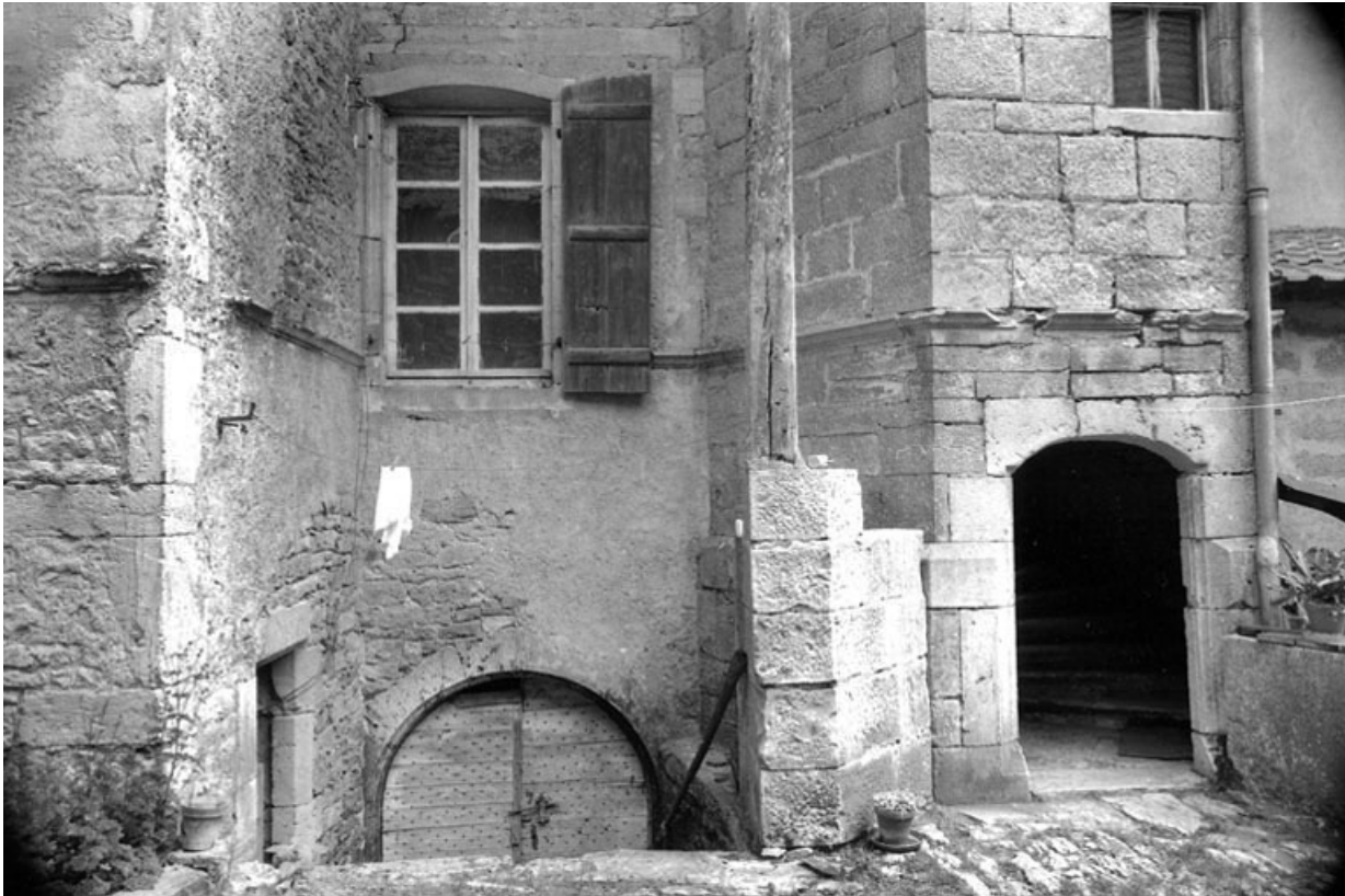
Entrée de la cave et de la tourelle d'escalier. 70, Pesmes, 2 rue de Granvelle
