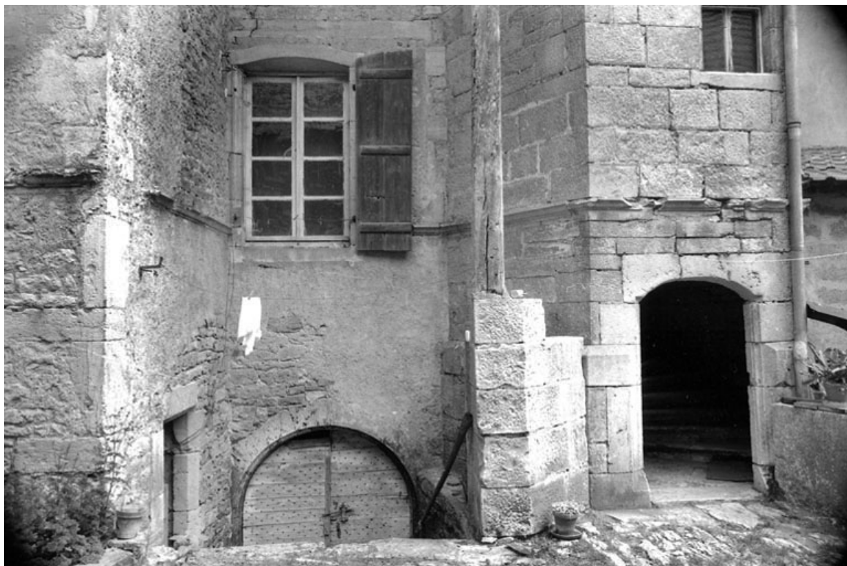
Entrée de la cave et de la tourelle d'escalier.
