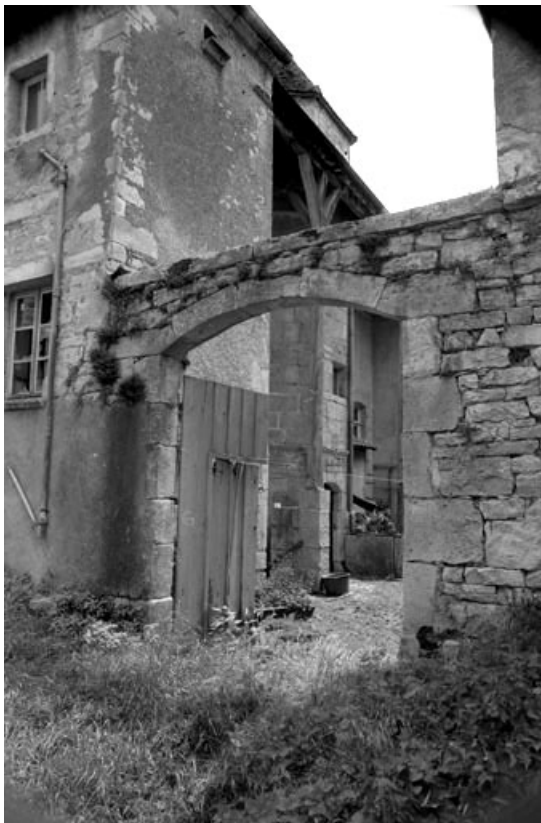
Cour sur façade postérieure.
