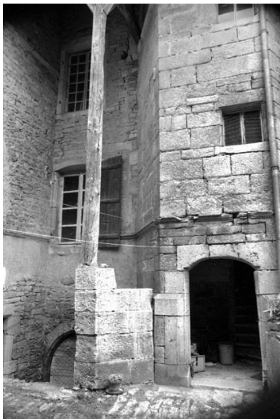
Entrée de cave et escalier en vis.
