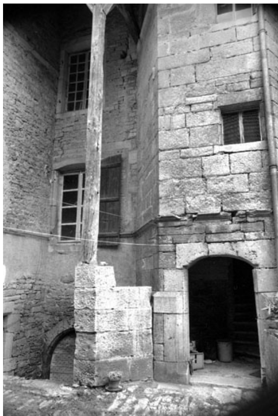
Entrée de cave et escalier en vis.
