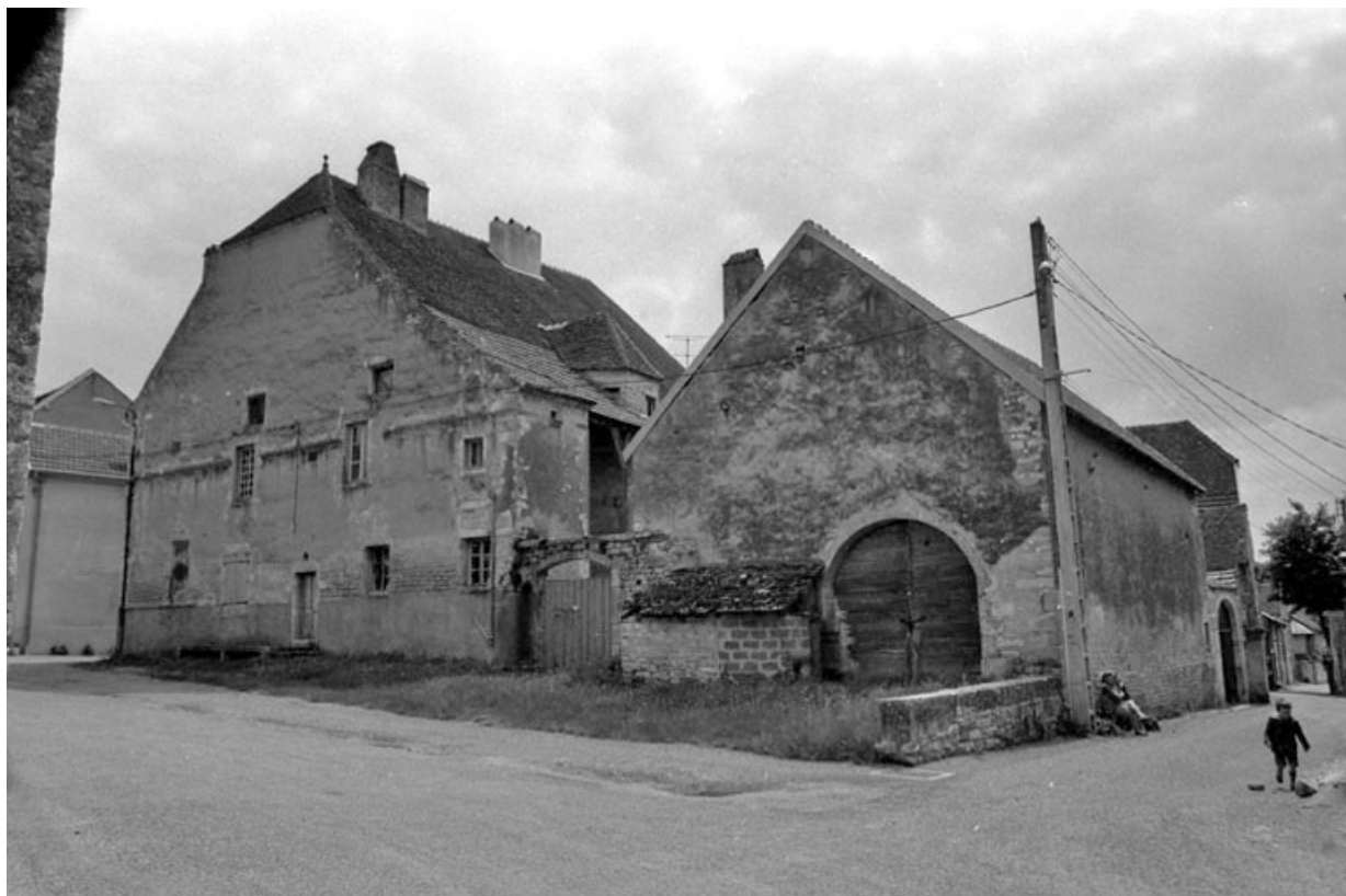
Façade latérale droite et bâtiment agricole.
