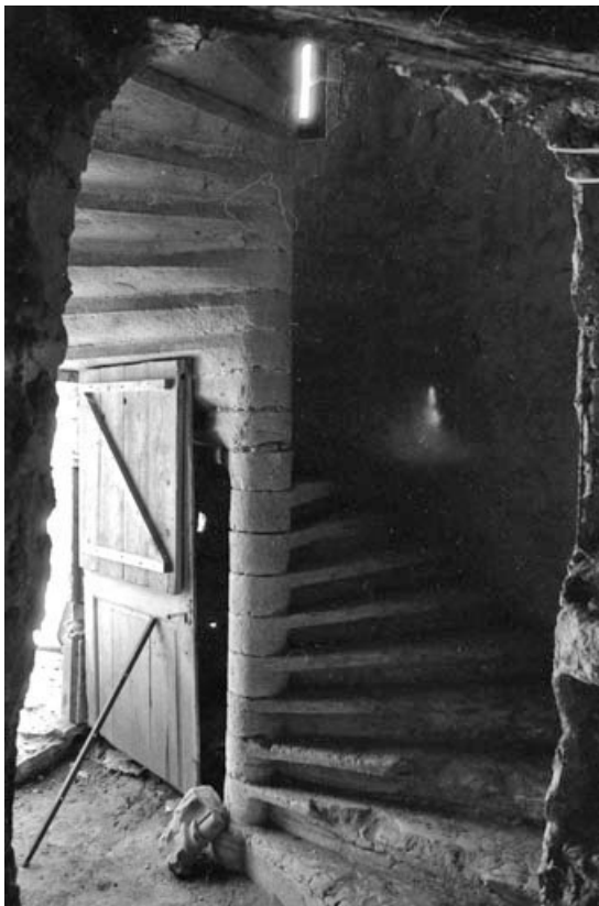
Détail : escalier en vis.
