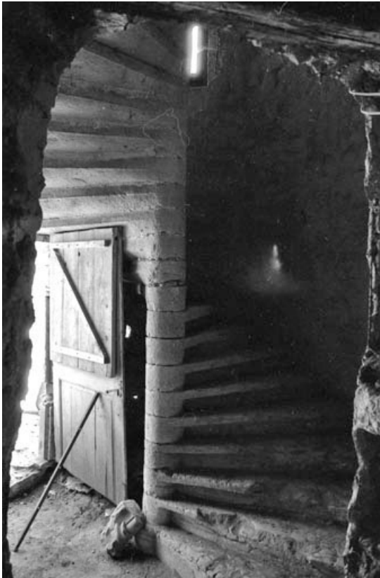
Détail : escalier en vis.
