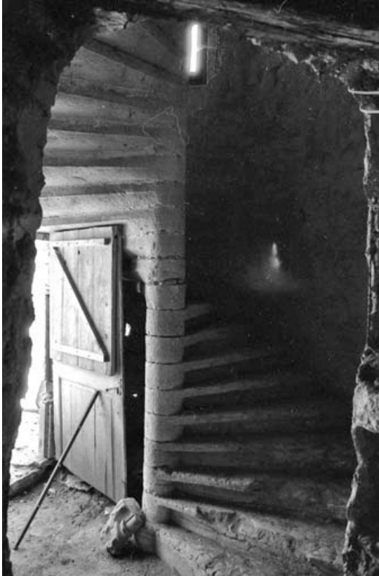
Détail : escalier en vis.
