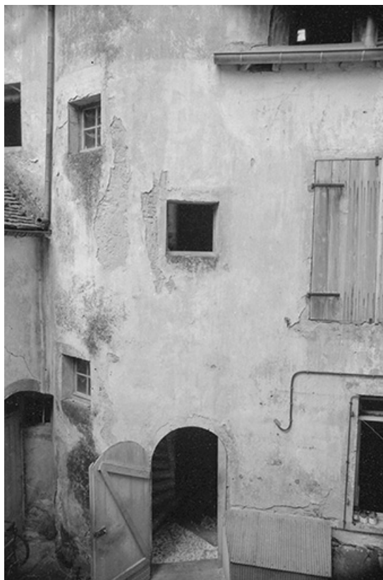
Bas de la tourelle d'escalier.
