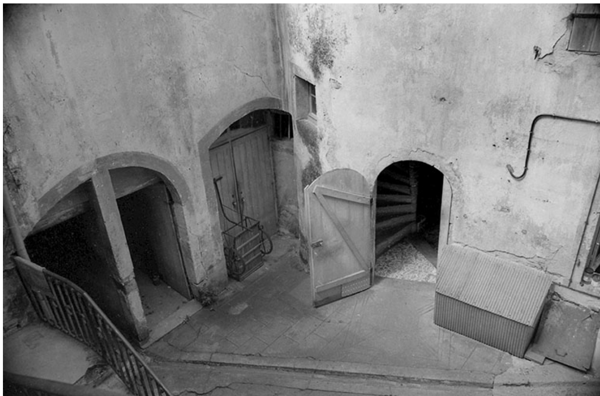
Accès aux bâtiments sur cour intérieure vus depuis l'étage.
