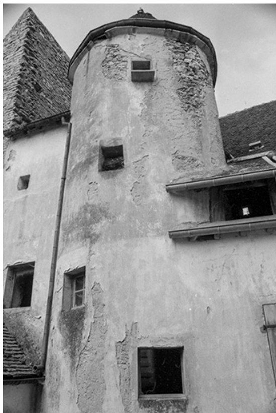
Tourelle d'escalier avec pigeonnier au dernier étage. 70, Pesmes, 6 Grande Rue
