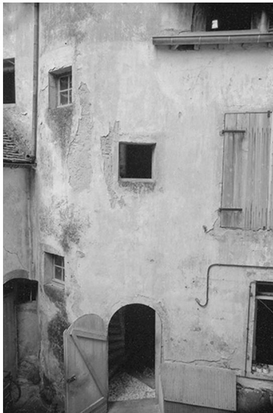
Bas de la tourelle d'escalier.
