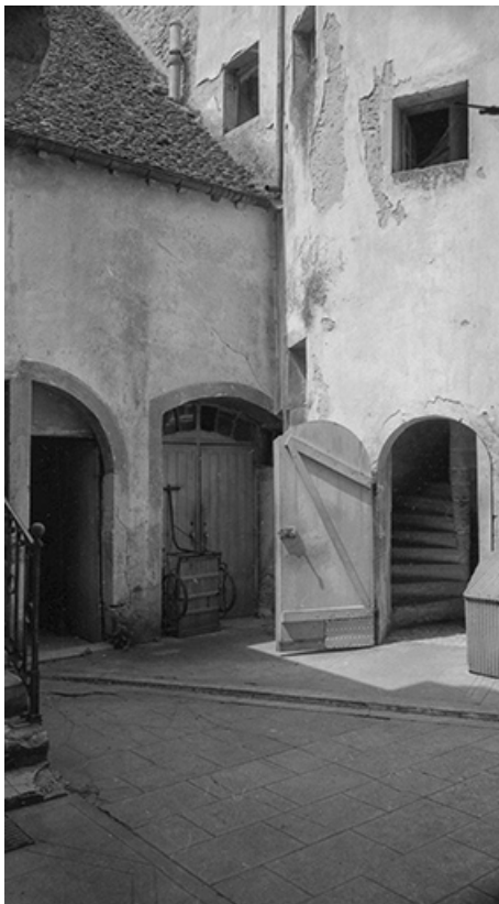
Batiments dans la cour intérieure.
