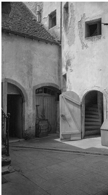
Batiments dans la cour intérieure.
