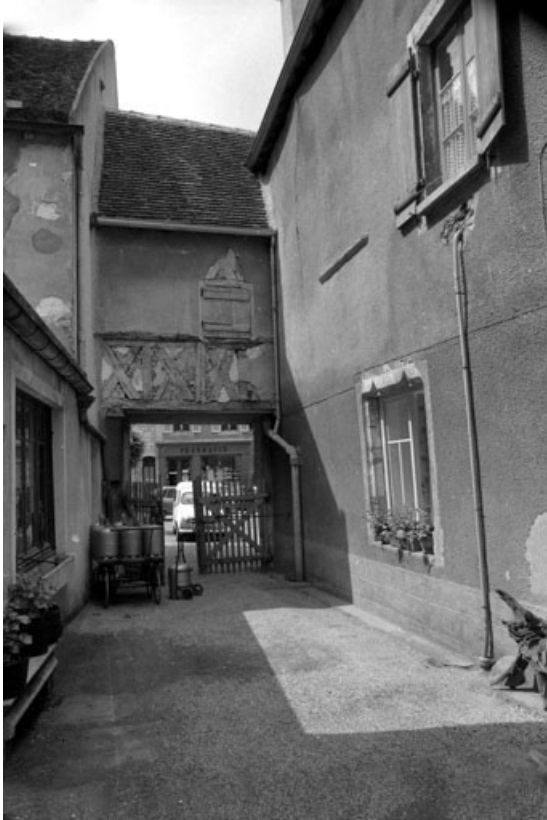
Détail passerelle couverte au-dessus de l'impasse. 70, Pesmes, 25 Grande Rue
