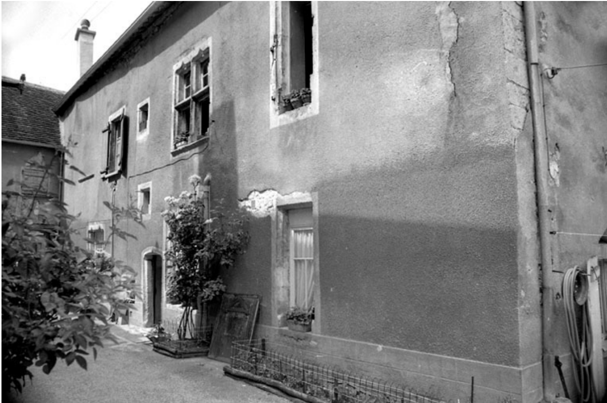
Façade sur impasse. 70, Pesmes
