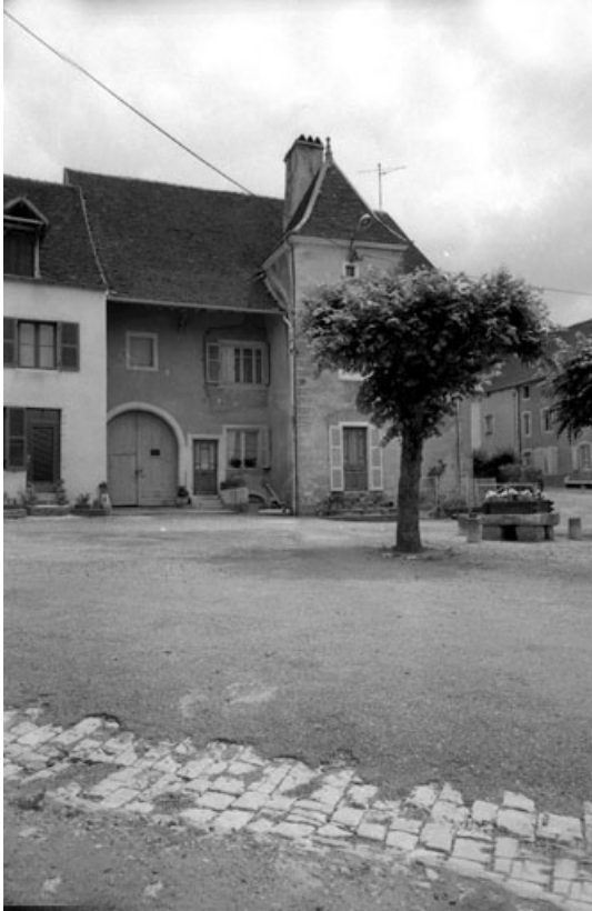
Façade antérieure : vue de trois quarts gauche. 70, Pesmes rue Saint-Hilaire
