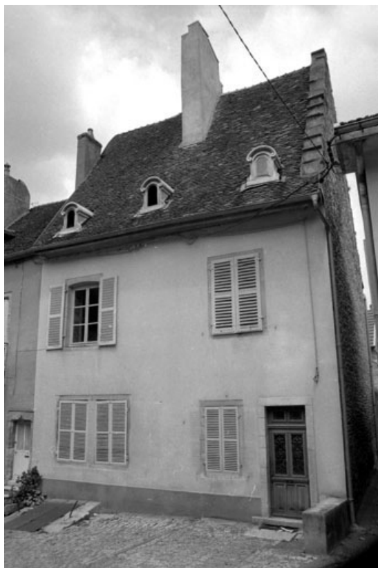
Façade antérieure de l'habitation sur rue Saint-Hilaire. 70, Pesmes
