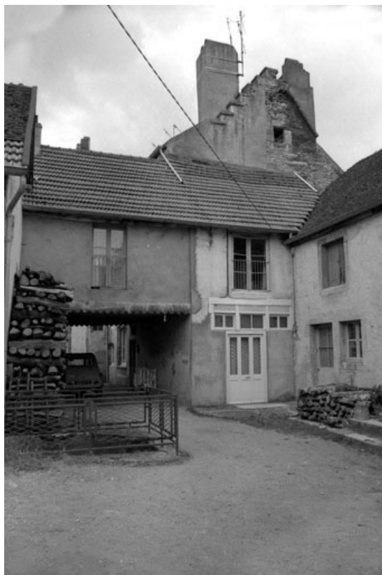
Façade postérieure et sommet de la tour d'escalier. 70, Pesmes ruelle Saint-Jacques
