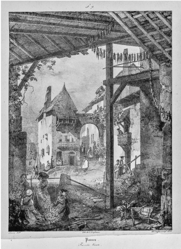
Vue d'ensemble de la maison au début du XIXe siècle. 70, Pesmes, 18 rue de la Vannoise
